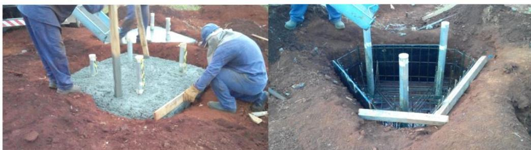
(b) concretagem do bloco de quatro.
