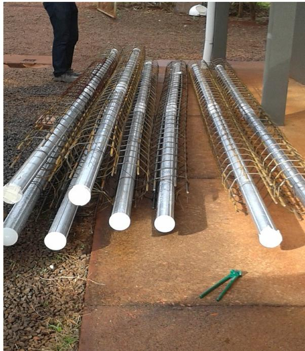
Figura 110 – Armadura das estacas com o tubo alumínio centralizado.
