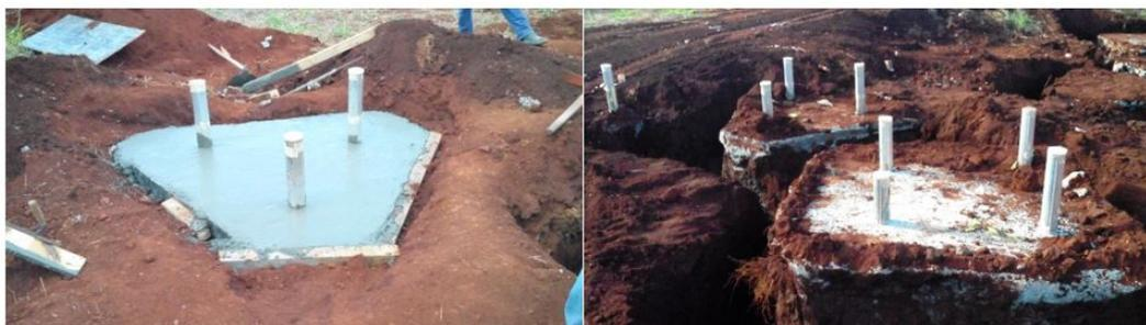
(d) Concretagem do bloco de três estacas.
