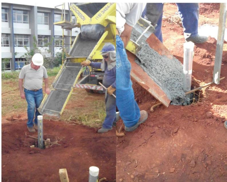
Figura 112 – Concretagem da estaca com armadura e tubo de alumínio.
