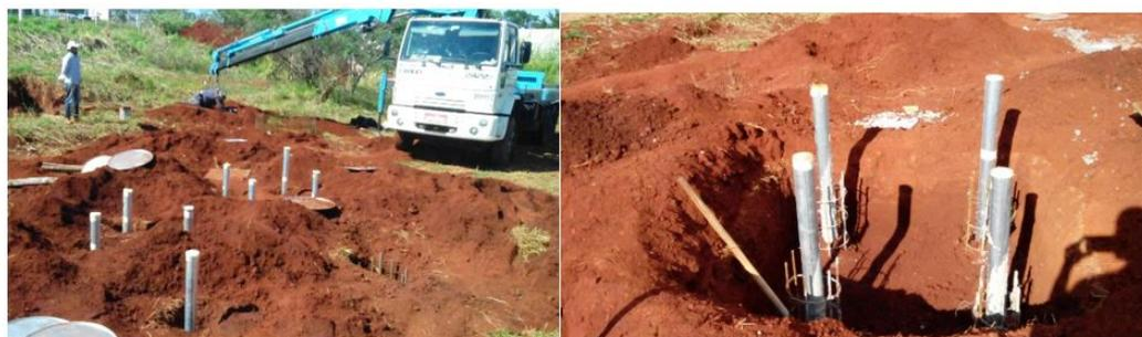
(a) Escavação para concretagem dos blocos de estacas.
