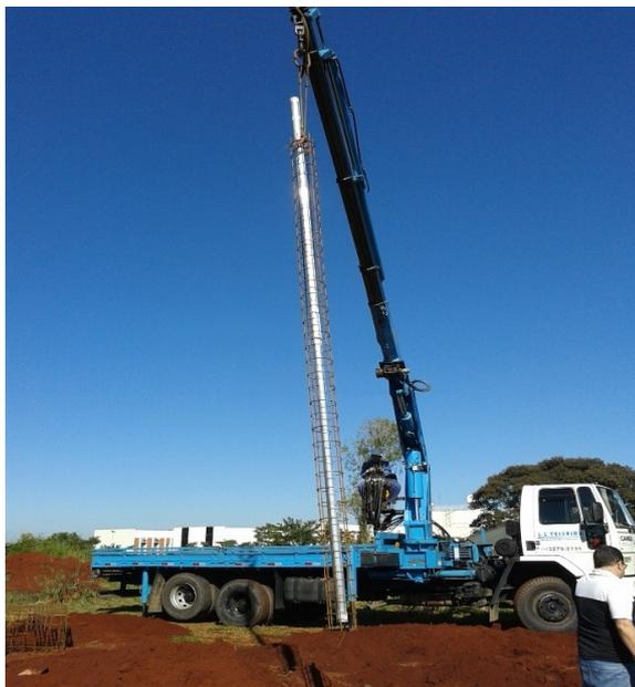
Figura 111 – Colocação do conjunto tubo e armadura dentro furo.
