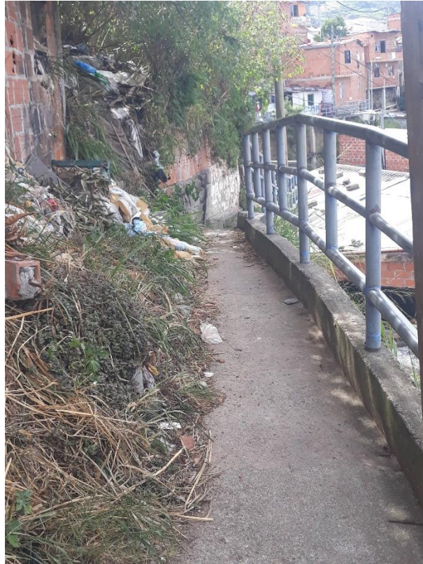
Figura 30 - Uma das vias de acesso da Comuna 13
