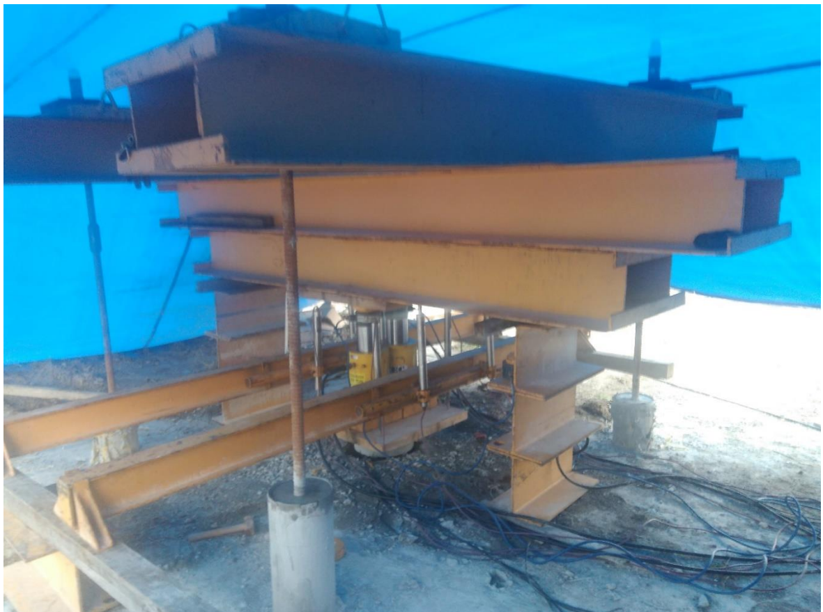
Figura 3.17 – Montagem em campo da prova de carga.
