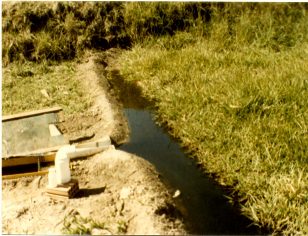
Figura 16. Valeta de coleta de efluente tratado e caixa de medição
