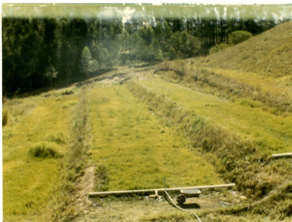
Figura 12. Visão geral das tubulações de distribuição.
