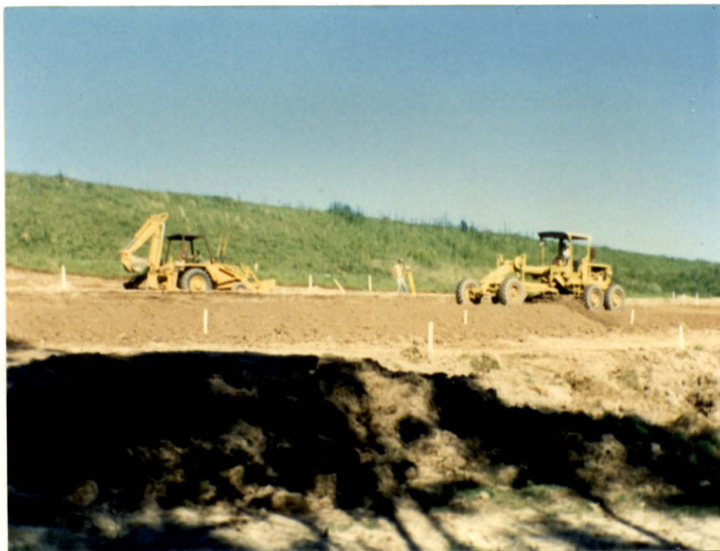
Figura 7. Motoniveladora construindo a rampa 2. A retroescavadeira está estacionada na rampa 1, já pronta.
