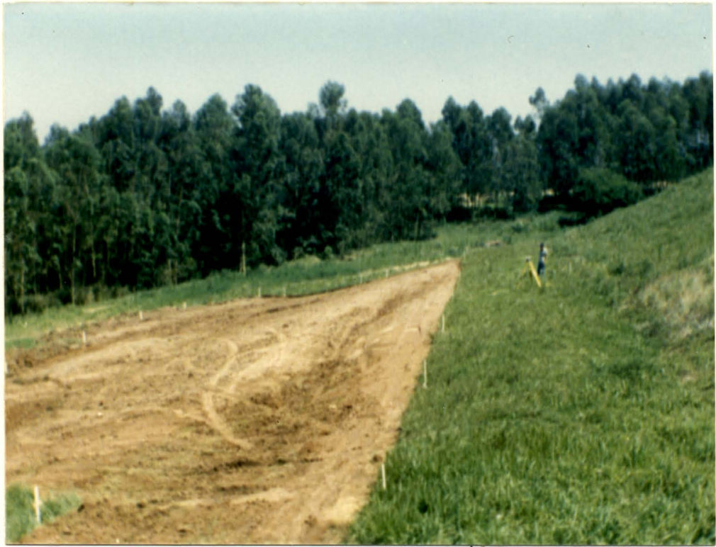
Figura 5. Local do experimento já limpo e estaqueado, vendo-se a direita o talude da terceira lagoa aneróbia.
