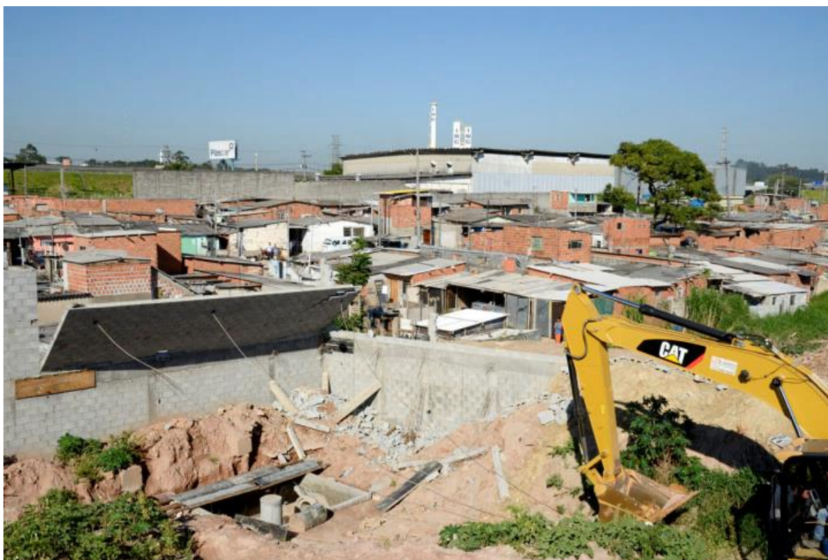
Figura 84 - Demolição do Muro
