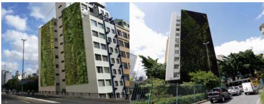
Figura 9 – Parede viva do edifício Huds e edifício Santa Cruz em São Paulo, SP. Fonte: G1.globo.com/sao-paulo/noticia.
