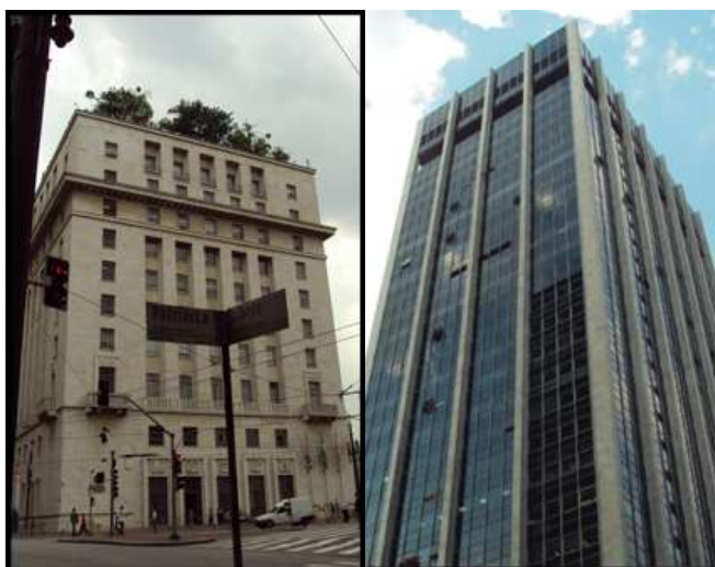
Figura 3 – Edifício Conde Matarazzo, Edifício Mercantil/ Finasa - São Paulo, SP. Fonte: www.usp.br/agen/?p=162345
