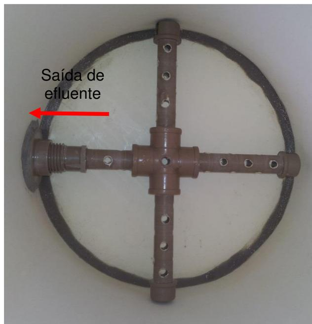
**Figura 15.** Tubulação inferior perfurada (com furos de  $\varnothing$  8 mm) para a drenagem de saída do vermifiltro
