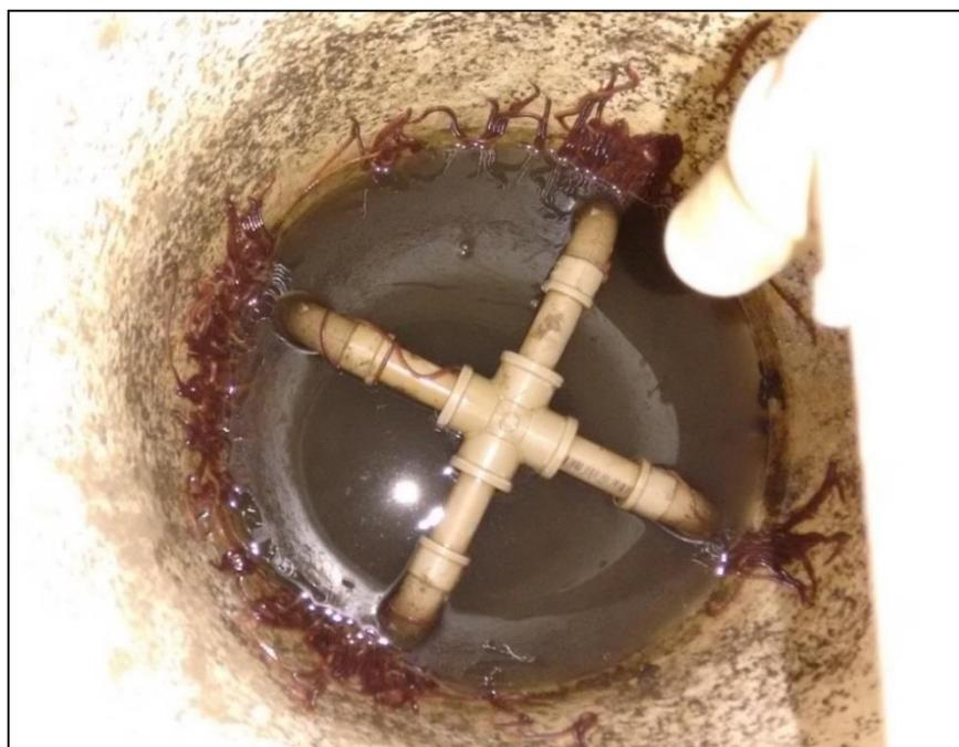
**Figura 20.** Topo do vermifiltro entupido após primeira tentativa malsucedida de operação
