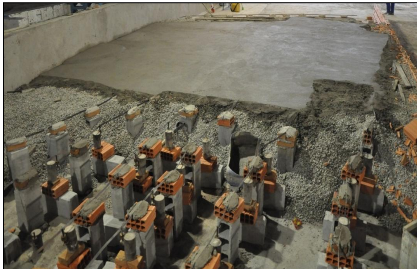
Foto 4.3. Modelação do piso com argamassa.
