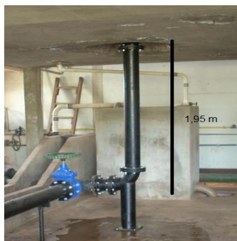
Figura 4.7 - Tubulação descendente e válvula
