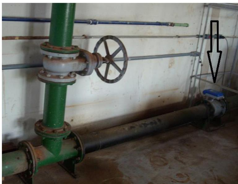
Figura 4.3: Medidor de vazão a montante
