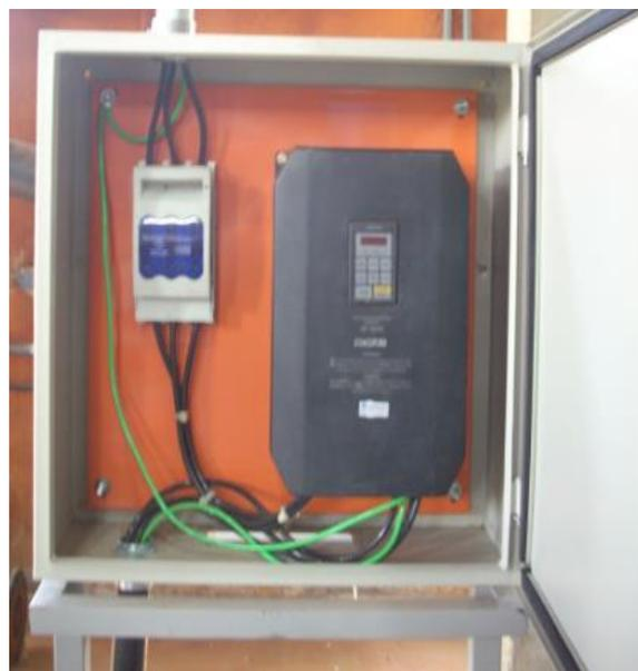
Figura 4.13: Inversor de frequência
