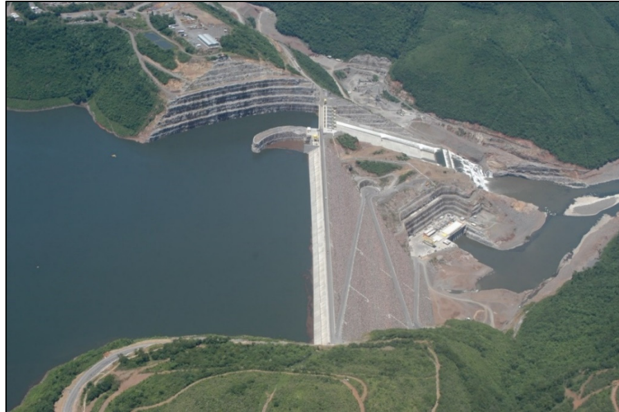
Figura 14 – Vista da Barragem
