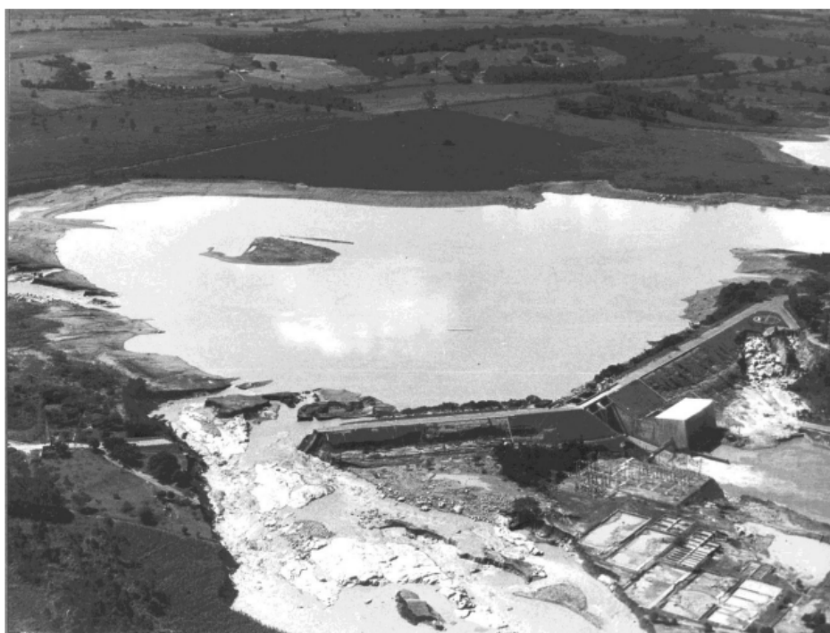
Figura 5 - Barragem da UHE Limoeiro após a ruptura
