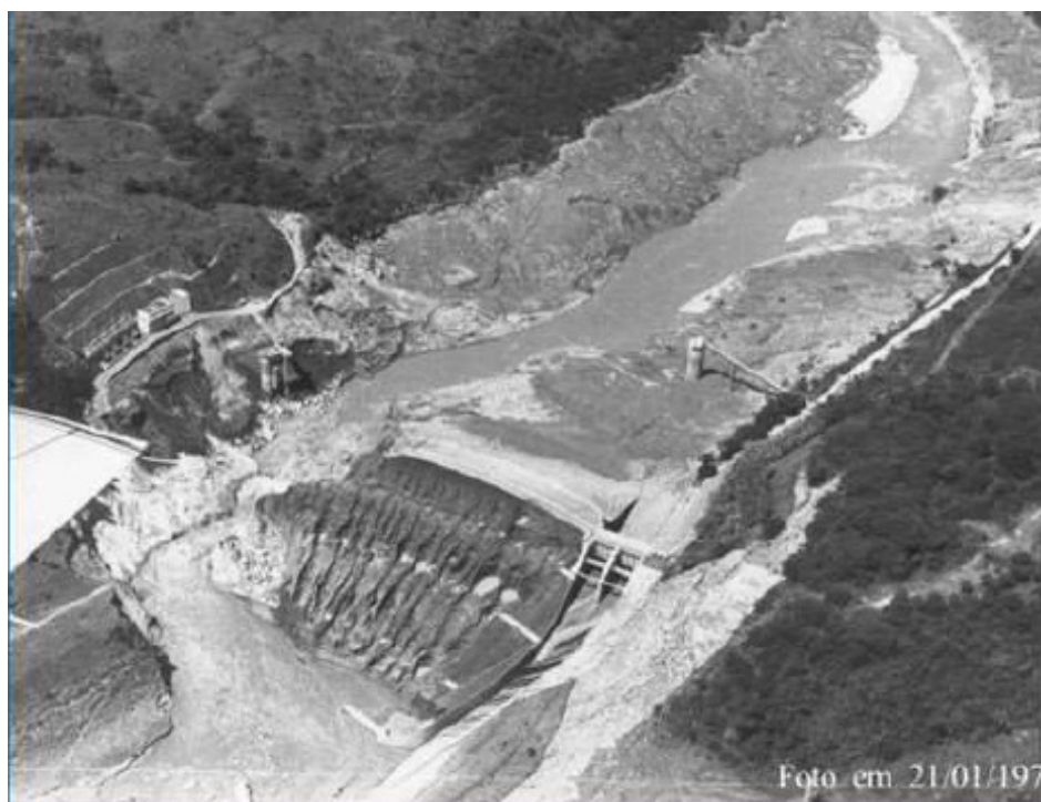
Figura 3 - Foto Aérea da barragem da UHE Euclides da Cunha após a ruptura
