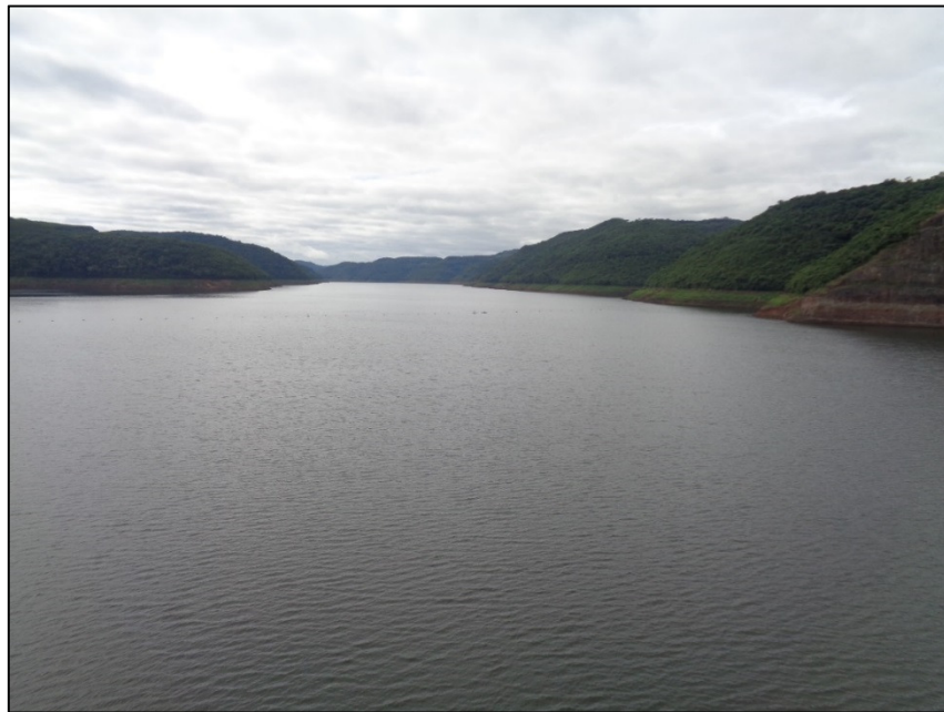
Figura 11 – Vista do Reservatório
