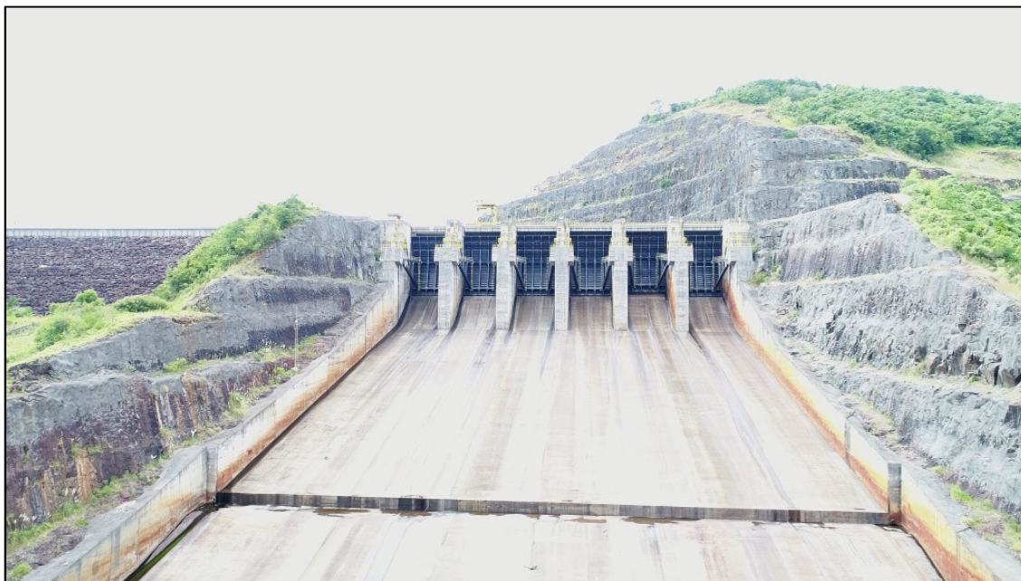
Figura 16 – Vista da Calha do Vertedouro
