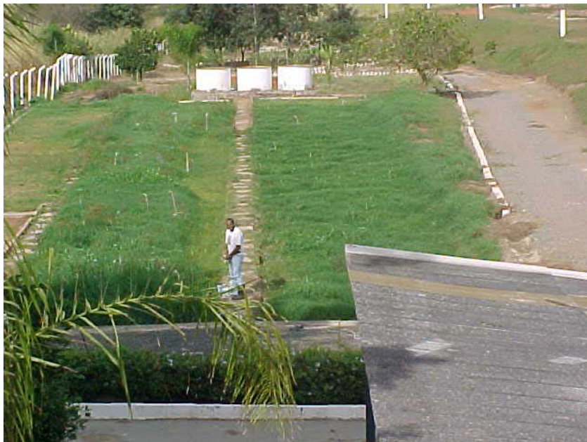
Figura 4.6 - Foto da rampa de escoamento superficial
