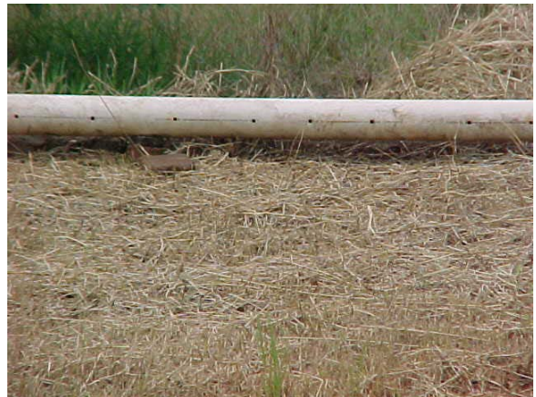
Figura 4.8 - Detalhe dos furos do sistema de distribuição
