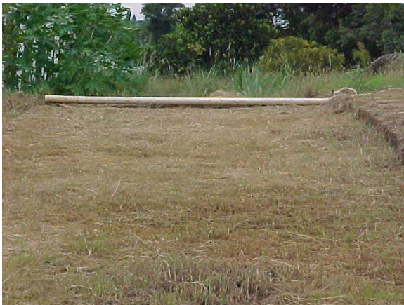
Figura 4.7 – Foto do sistema de distribuição
