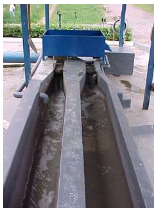
Figura 4.3 – Detalhe do tratamento preliminar
