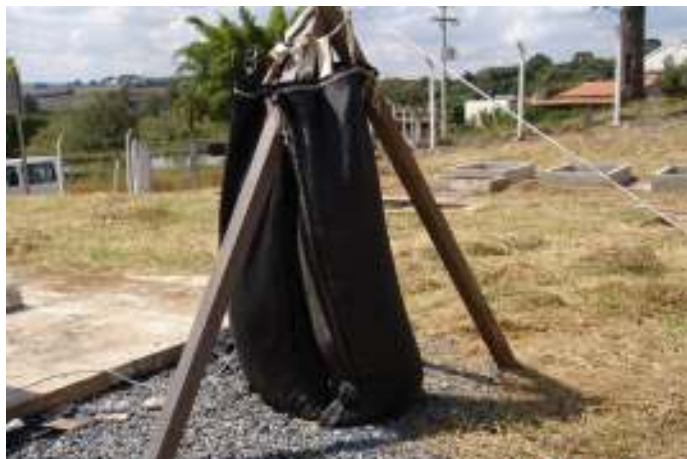
Figura 18 - Contentores de geotêxtil utilizados para desaguoamento do lodo séptico
