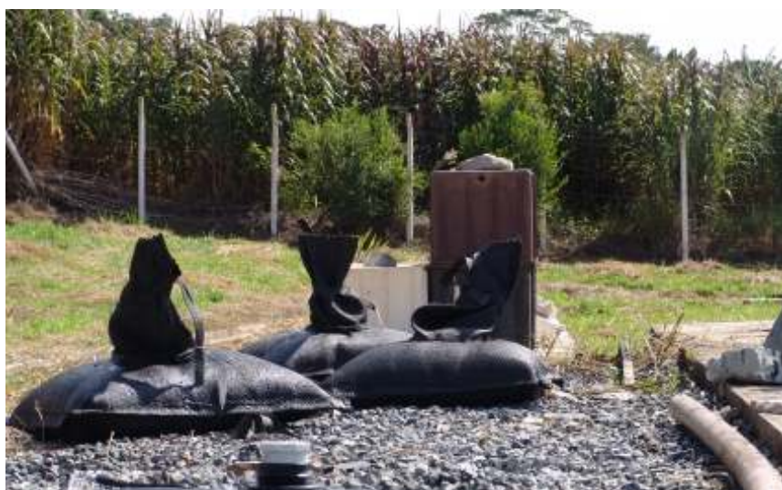
Figura 7 - Disposição dos contentores de geotêxtil para desaguamento
