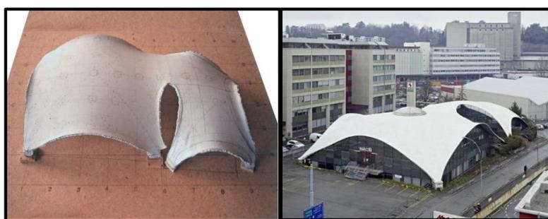
Figura 12. Modelo físico da membrana suspensa para a fábrica Sicli SA, Genebra, Heinz Isler. Fonte: <https://www.hesge.ch/head/eventement/2017/association-sicli-ouverture-poste>. Acesso 10/2018.
