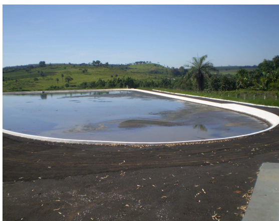
Figura 4.9 – Lagoa anaeróbia da ETE Itirapuã
