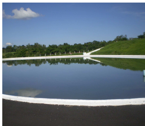
Figura 4. 10 – Lagoa facultativa 1 da ETE Itirapuã
