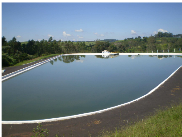
Figura 4.11 - Lagoa facultativa 2 da ETE Itirapuã
