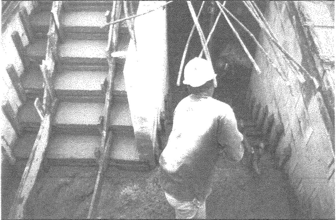
**Figura 4.30.** – Execução da Escada de Concreto Moldada “in loco”
