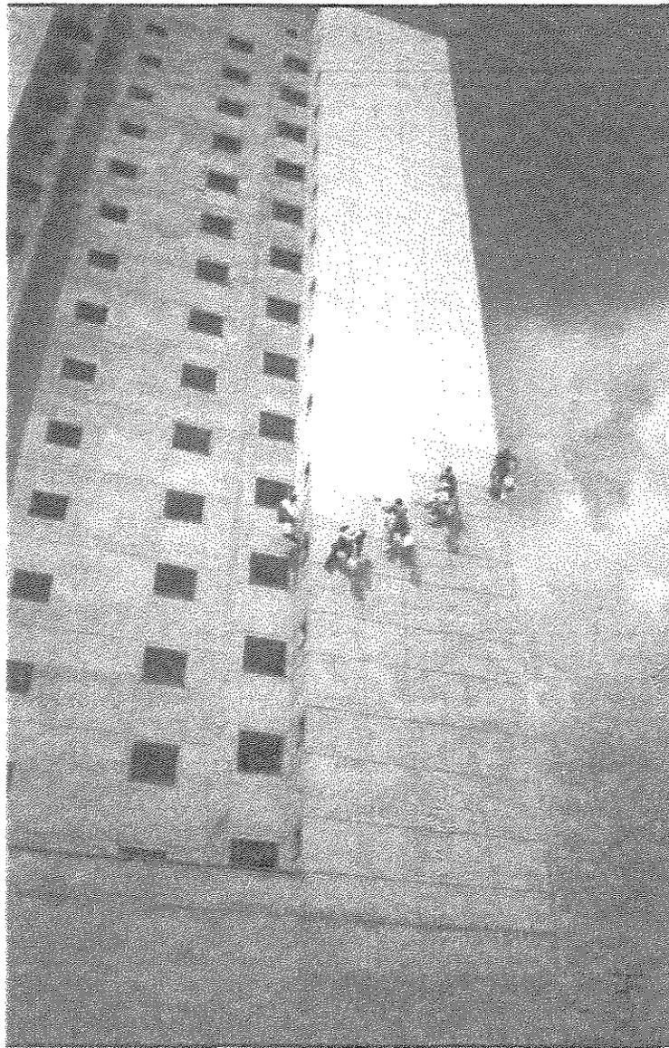
**Figura 4.38.** – Execução da Pintura Externa com Textura à Rolo
