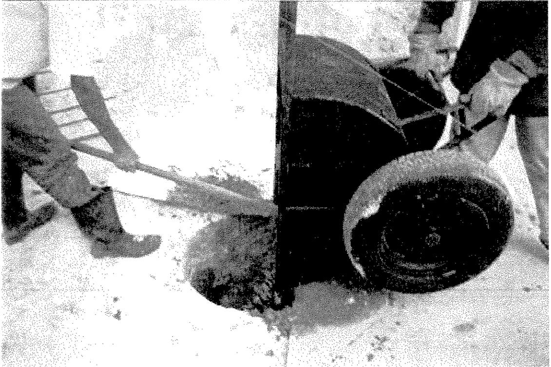
**Figura 4.13.** – Concretagem do Tubulão
