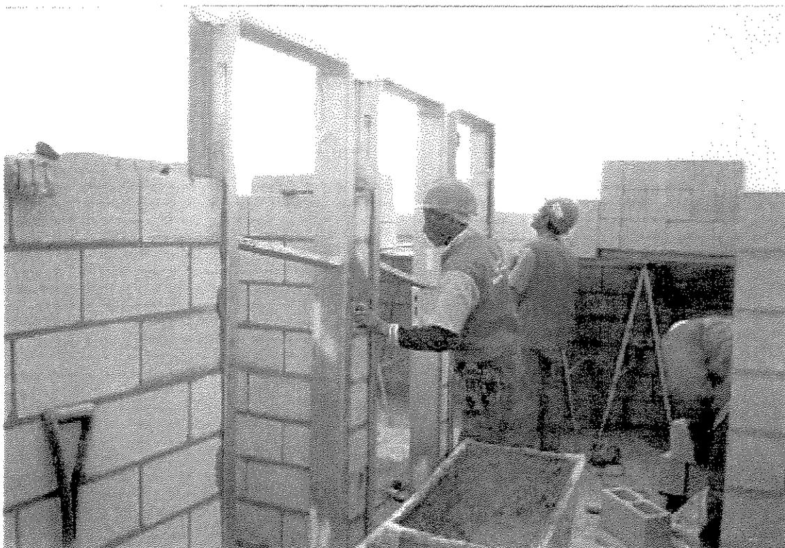
**Figura 4.22.** – Colocação dos Batentes Metálicos
