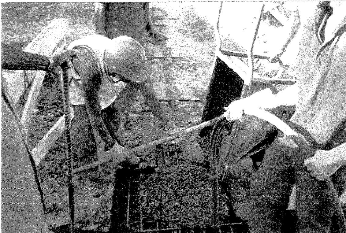
**Figura 4.14.** – Concretagem de Blocos e Vigas Baldrame.
