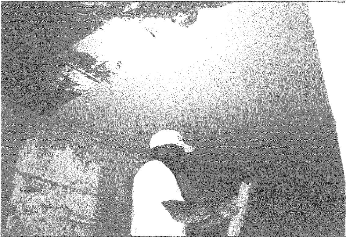
**Figura 4.35.** – Aplicação de Gesso Liso na Laje e Paredes
