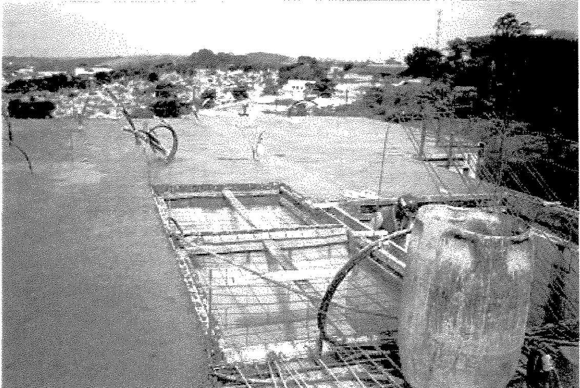
**Figura 4.31.** – Poço do Elevador – Detalhe das Ferragens de Proteção
