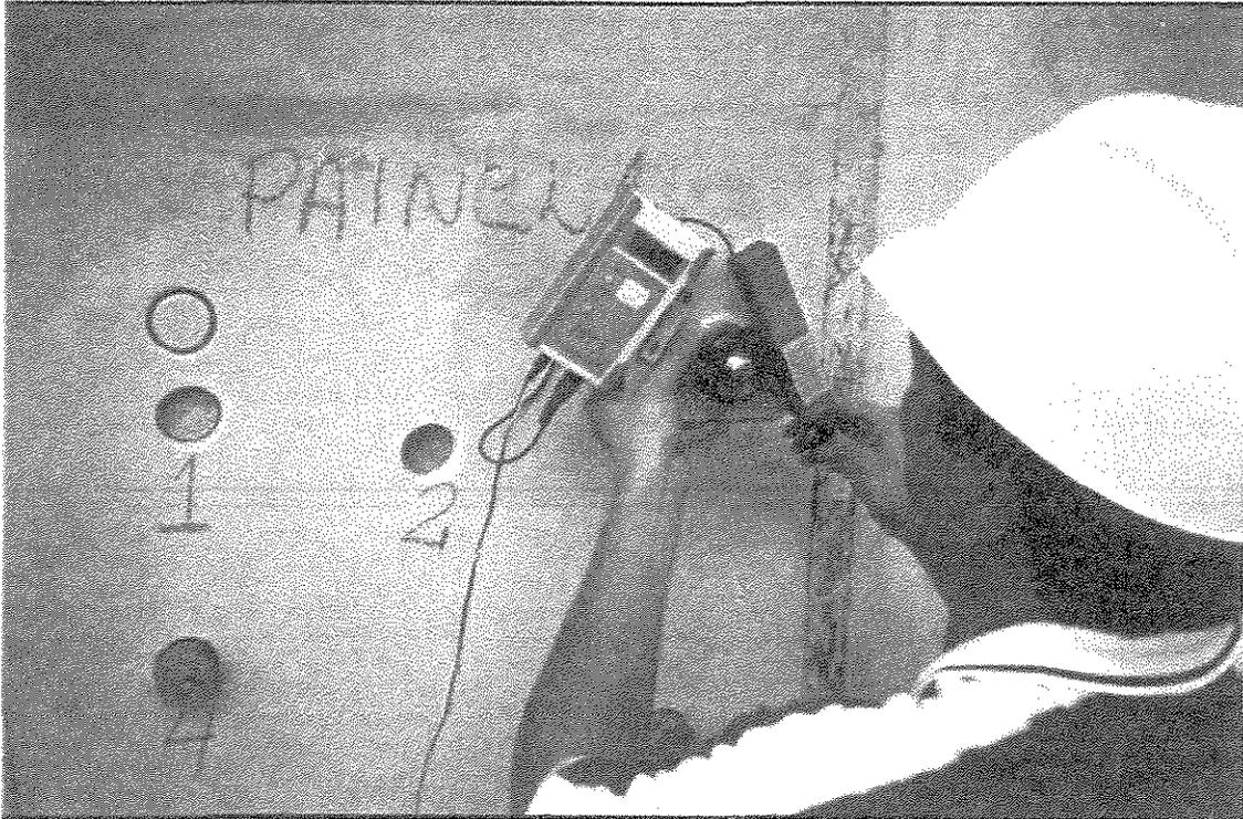
**Figura 4.48.** – Ensaio de Aderência da Argamassa de Revestimento
