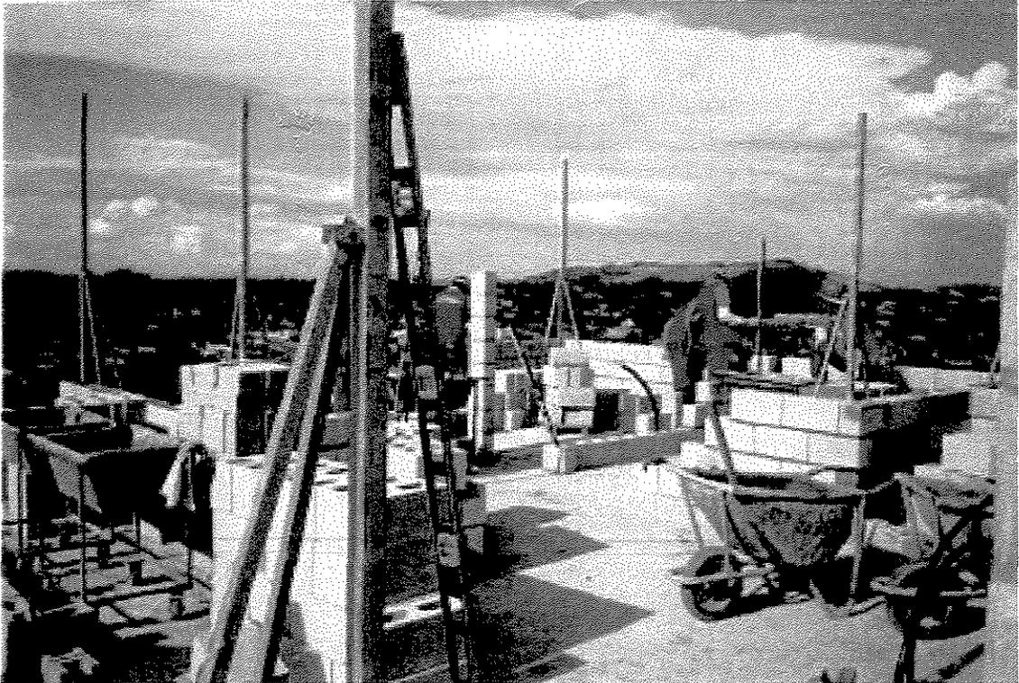
**Figura 4.19.** – Diversas Ferramentas para Execução da Alvenaria
