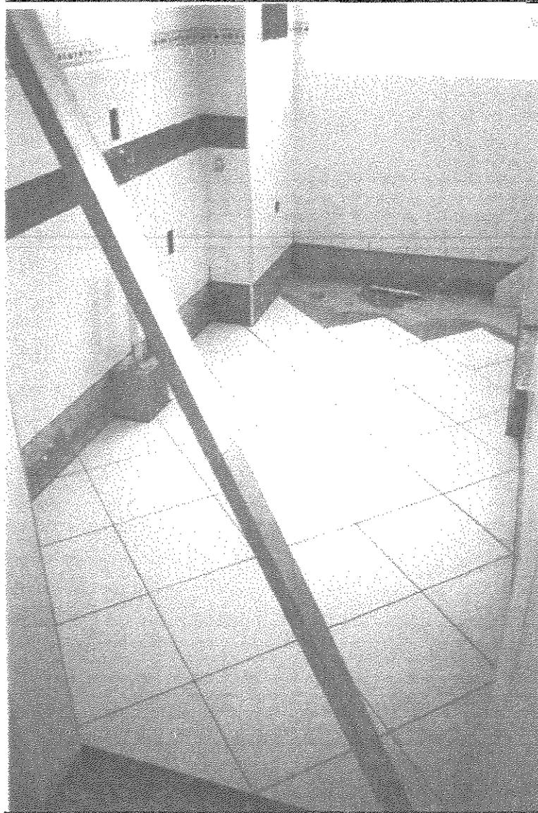
**Figura 4.37.** – Assentamento dos Azulejos e Pisos Cerâmicos
