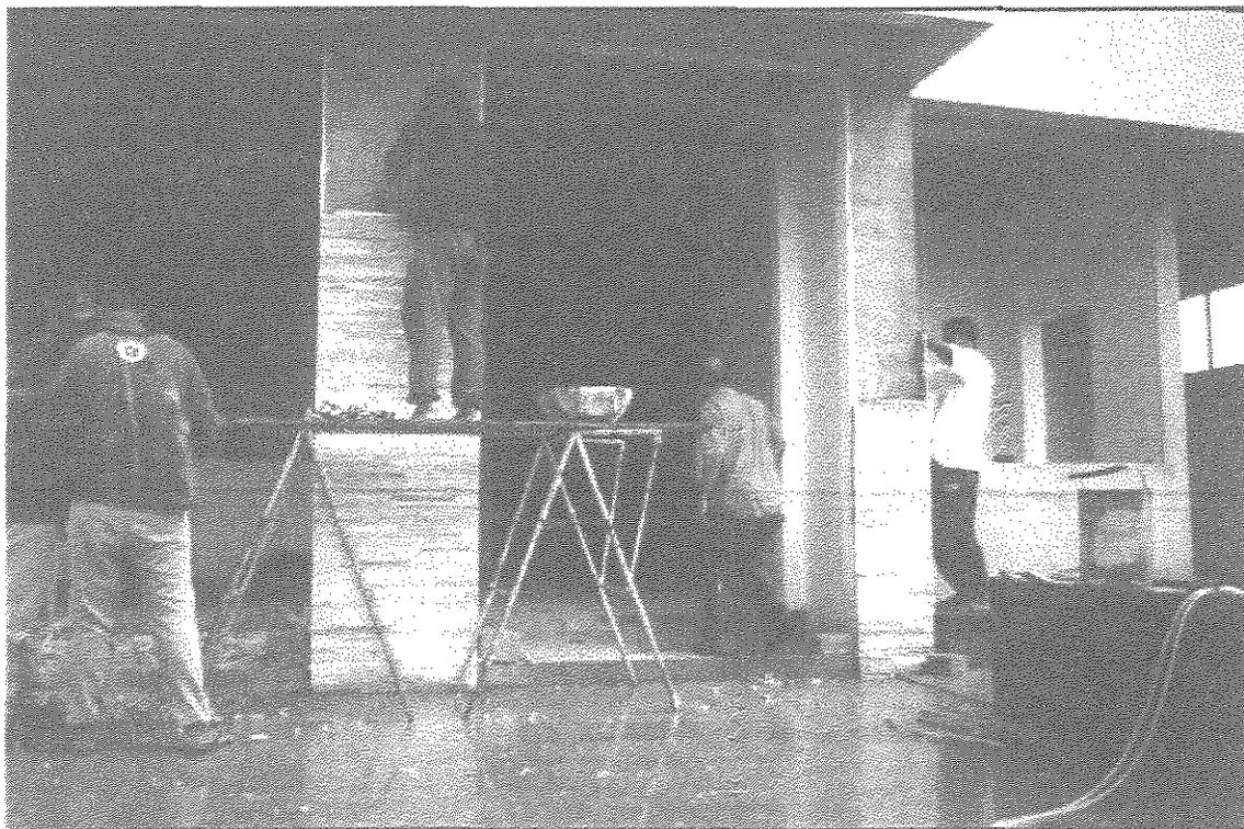
**Figura 4.39.** – Execução do Revestimento em Pedra Tipo "Canjica"
