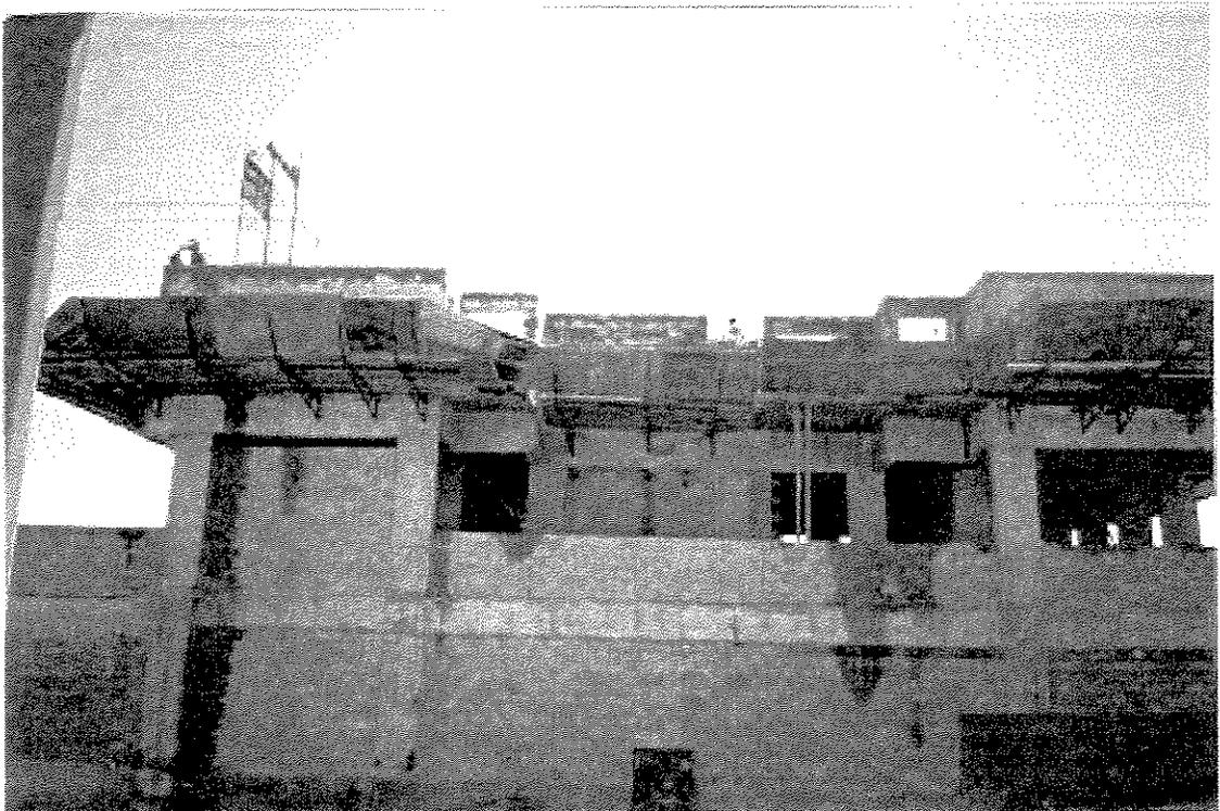
**Figura 4.16.** – Vigas de Transição na Cobertura do Pavimento Térreo
