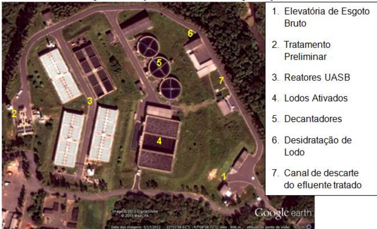
Figura 8 - Estação de Tratamento de Esgoto Piçarrão
