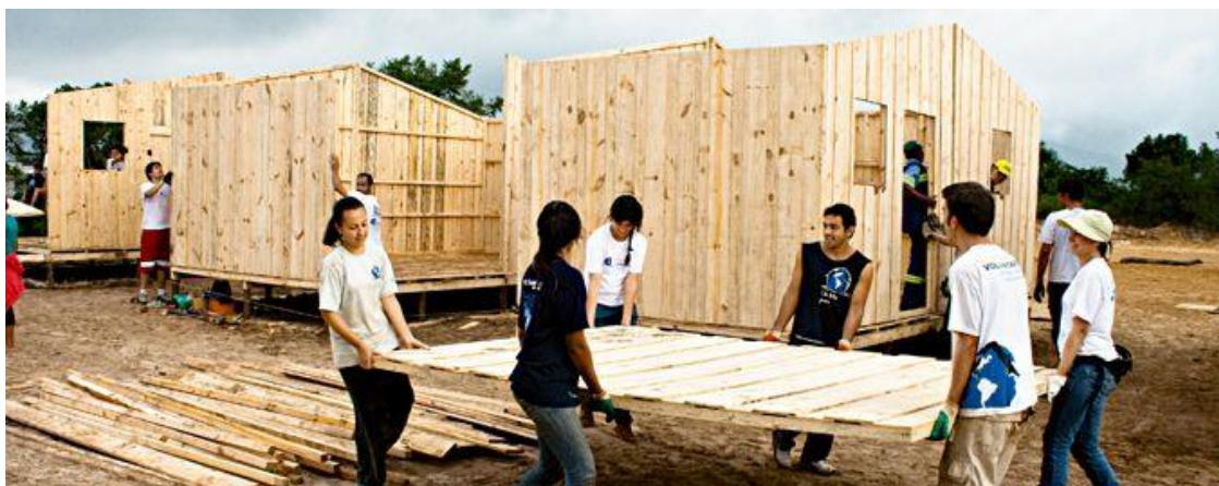
Figura 4.2.4.2 Voluntários durante a construção das Casas de Emergência TETO
