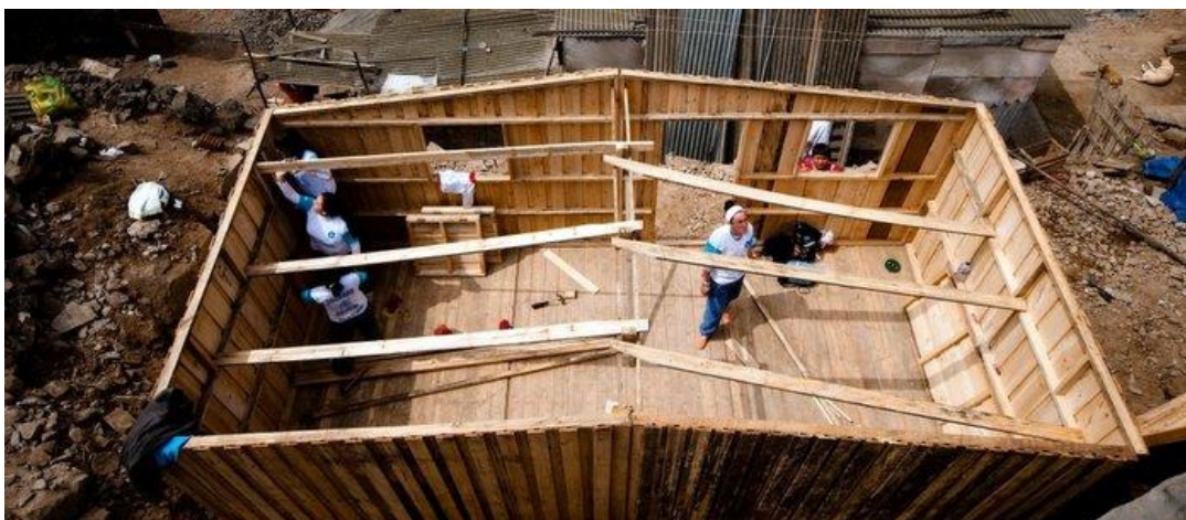
Figura 4.2.4.5 Construção de casa de emergência TETO
