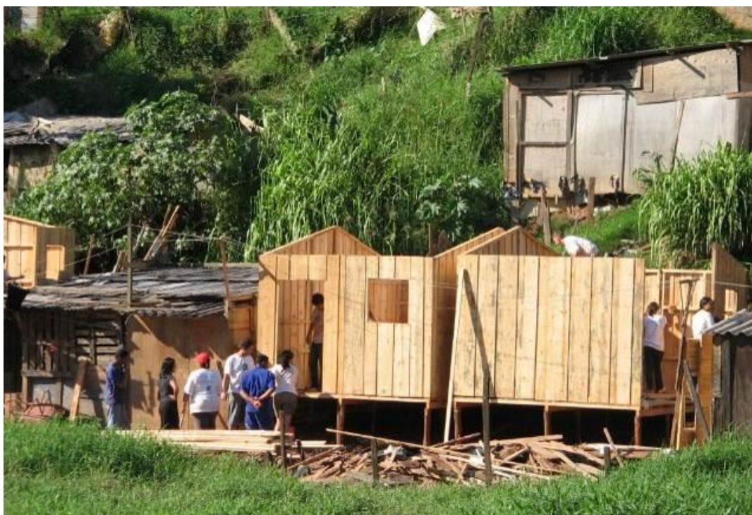
Figura 4.2.4.6 Casas de Emergência TETO com aberturas voltadas às laterais menores
