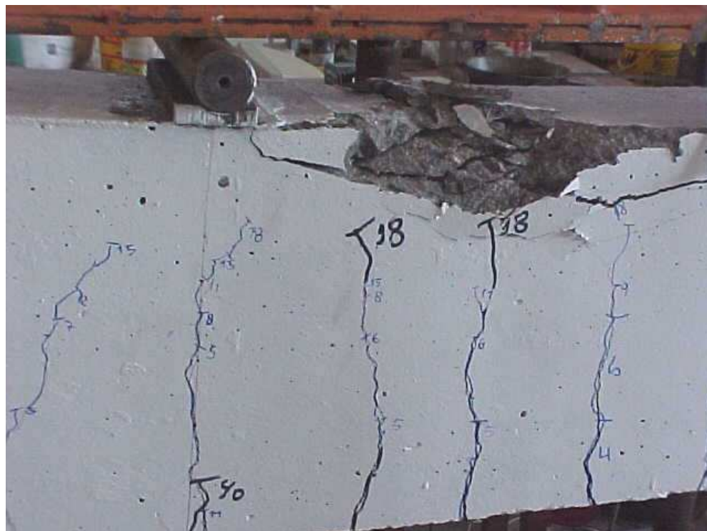
FIGURA A.7 – Progressão das fissuras no momento da ruptura
