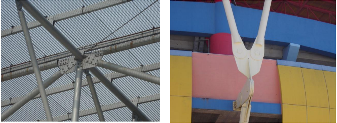
Figura 5 – Ligações tubulares em chapa (Arquivo Pessoal)
