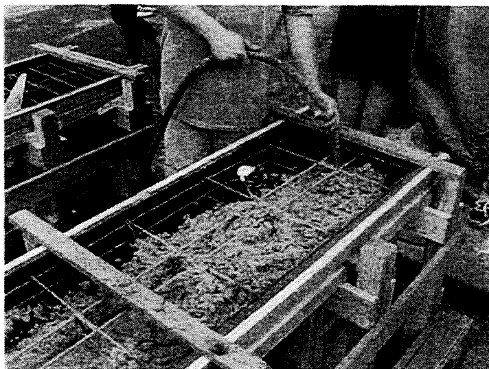
FIGURA 6.14 Detalhe do adensamento do concreto da viga V1, com o uso de vibrador.
