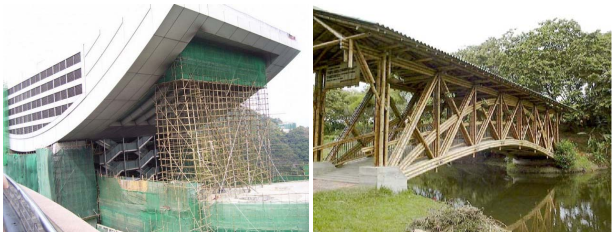
Figura 2. Andaimes de bambu utilizados na China e estrutura de ponte em bambu. Fonte: Engenharia e Construção (2013) e Buttner (2012).
