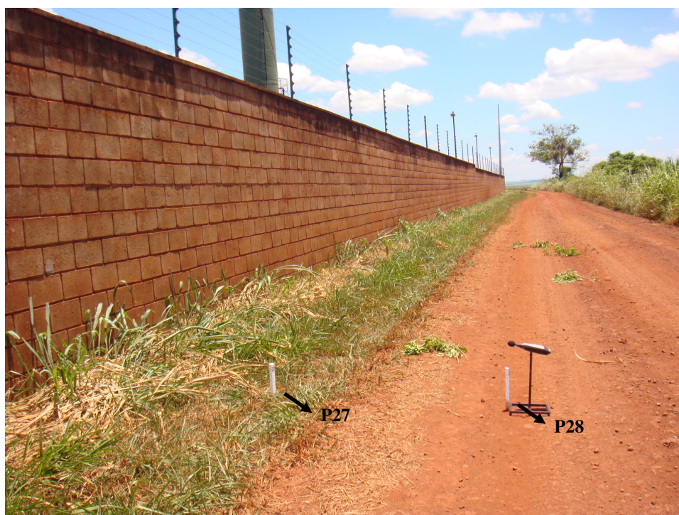
Figura 8.14 – Avaliação de barreira acústica – face oposta à geração do ruído
