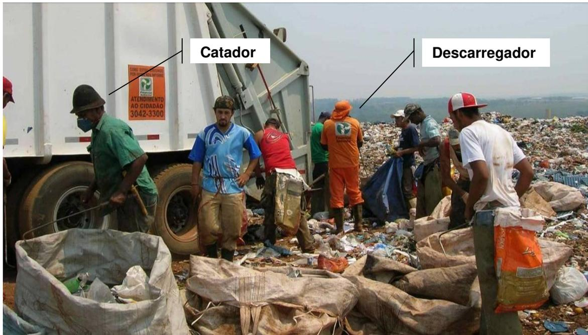
**Figura 5.61** Aterro controlado de Campo Grande/MS – abertura da porta de descarregamento do veículo coletor / catadores e descarregador
