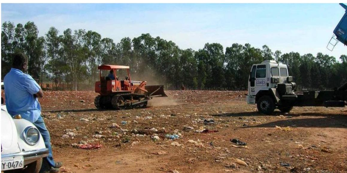
Verificou-se que a cobertura do resíduo sólido, quando realizada imediatamente após o descarregamento, proporciona melhores condições do ambiente de trabalho, notadamente, sob o aspecto de diminuição de odores, de partículas de resíduo sólido em suspensão; e, de redução da quantidade de vetores, tais como aves, ratos, moscas e outros.
