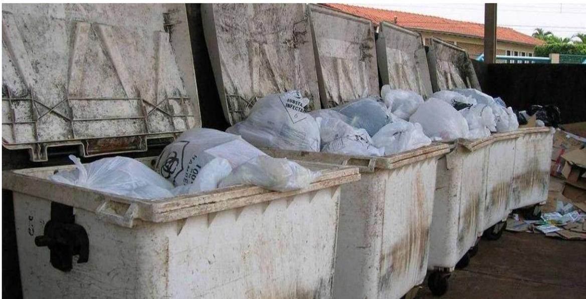
Na Figura 5.29 observa-se que o abrigo externo de resíduo da unidade de saúde onde estava sendo realizada a coleta (hospital) não era revestido internamente (piso e paredes) com material liso, resistente, lavável, impermeável e de cor branca, não possibilitando higienização adequada, conforme estabelecem ABNT e MTE (ABNT, 1993c; MTE, 2010v).
