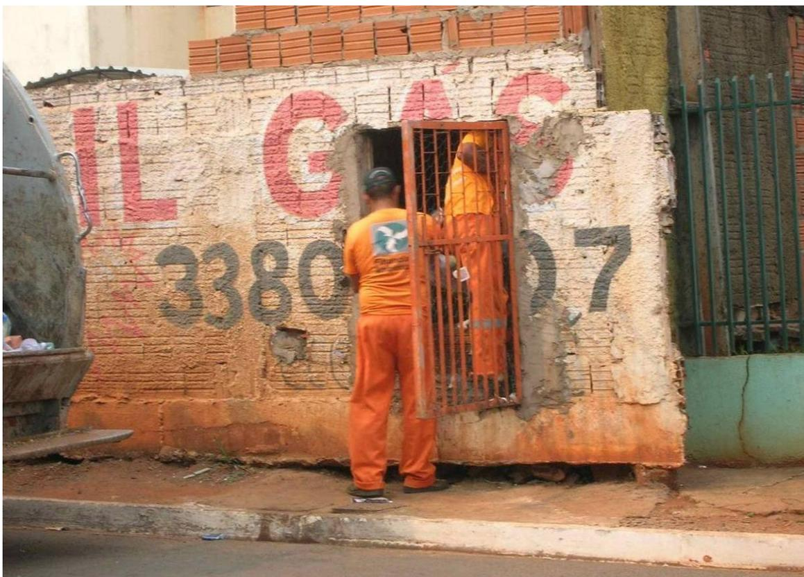
**Figura 5.21** Coleta domiciliar - Campo Grande/MS – irregularidade em abrigo externo de resíduo – existência de obstáculo no percurso de acesso ao interior do abrigo
