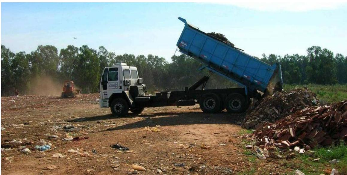
**Figura 5.55** Aterro sanitário de Penápolis/SP - frente de trabalho – detalhe do trator de esteiras
