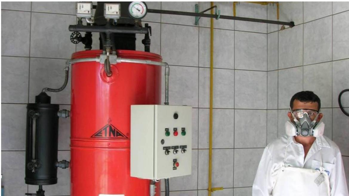
**Figura 5.47** Tratamento de resíduo sólido de serviços de saúde – Penápolis/SP – resíduo preparado para ser introduzido no autoclave
