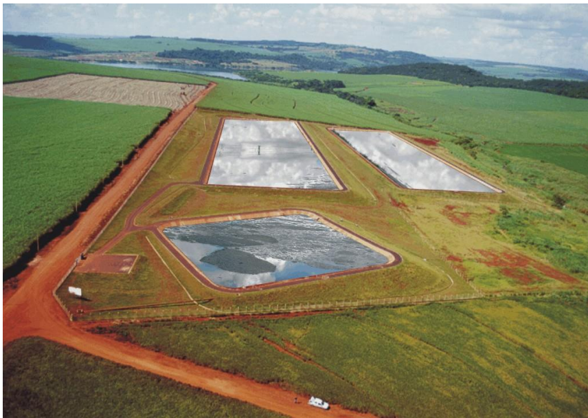
Figura 3.1 - Foto aérea da ETE Igarapava/SP – lagoas de estabilização
