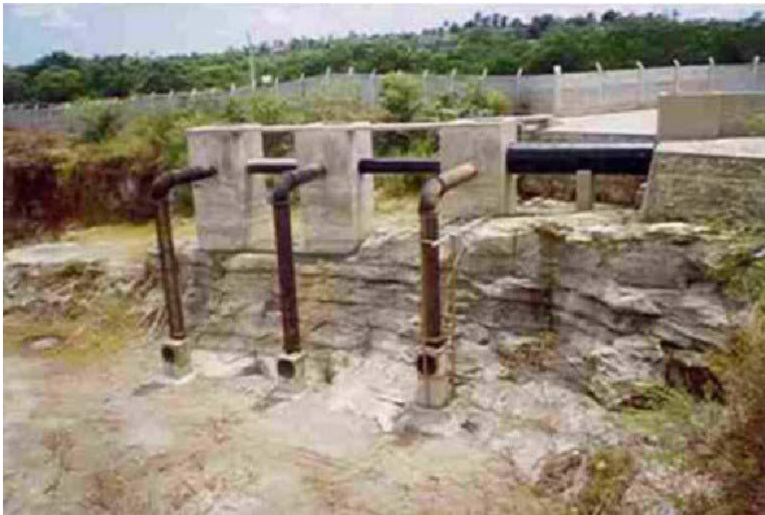
Figura 3.5 - Dispositivo de entrada da lagoa anaeróbia do Roger antes do início do funcionamento – João Pessoa/PB
