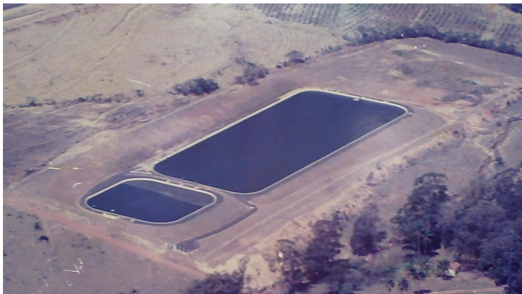
Figura 4.3 - Foto aérea da ETE Pedregulho
