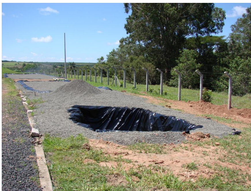
Figura 4.15 - Preparação do local com lonas e pedra brita – ETE Pedregulho em 27/11/2008
