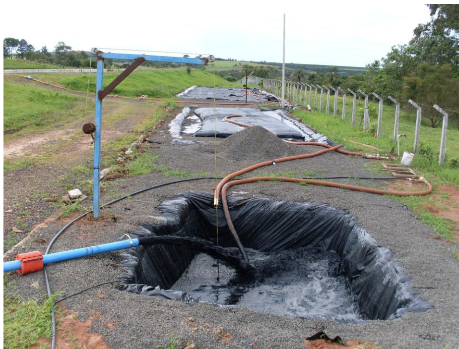
Figura 4.26 - Lodo dragado para depois ser bombeado para os bags pela bomba instalada no tanque – ETE Pedregulho
