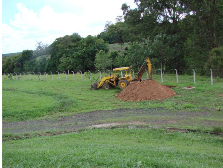
Figura 4.13 - Início da preparação do local dos bags – ETE Pedregulho em 19/11/2008
