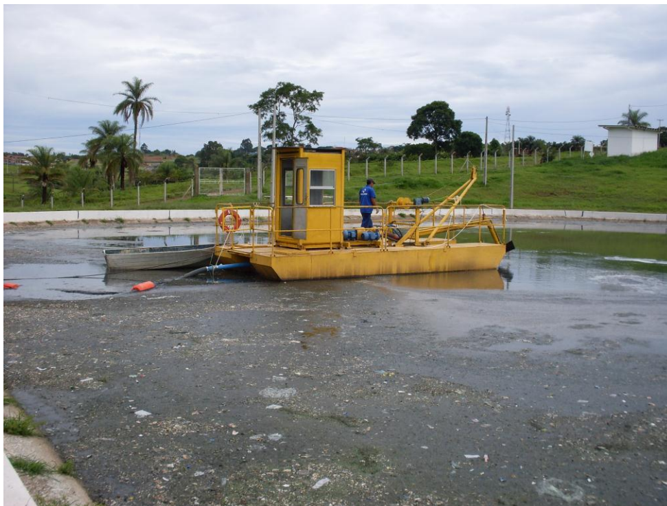
Figura 4.25 - Dragagem para bombeamento da lagoa anaeróbia para a caixa de mistura – ETE Pedregulho
