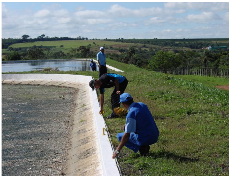
Figura 4.10 - Demarcação da lagoa anaeróbia da ETE Pedregulho (2008), utilizando-se a trena e tinta (5m)
