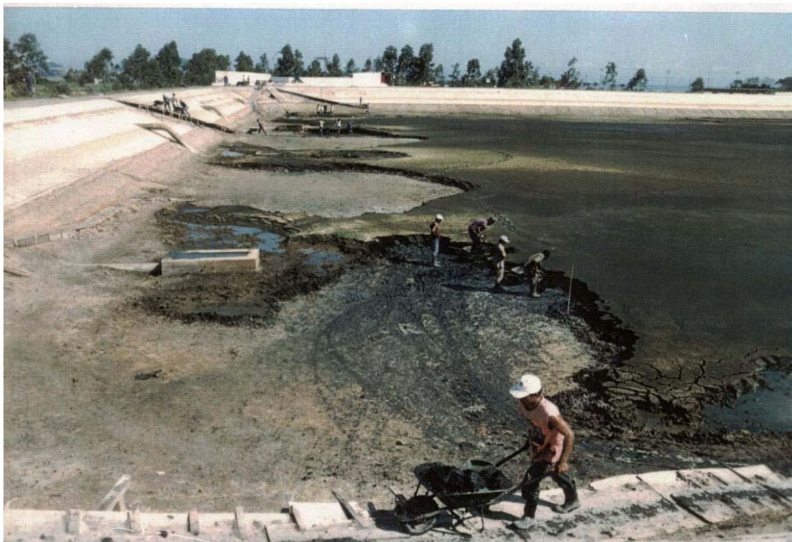
Figura 3.6 – Remoção manual do lodo de lagoa anaeróbia - Vitória (ES)
