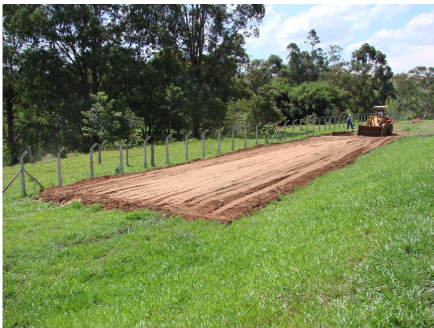
Figura 4.14 - Preparação do local a ser instalado um dos bags – ETE Pedregulho em 20/11/2008
