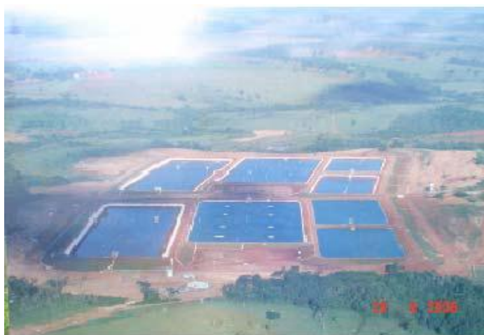
Figura 3.13 - Vista aérea da ETE Anápolis - GO
