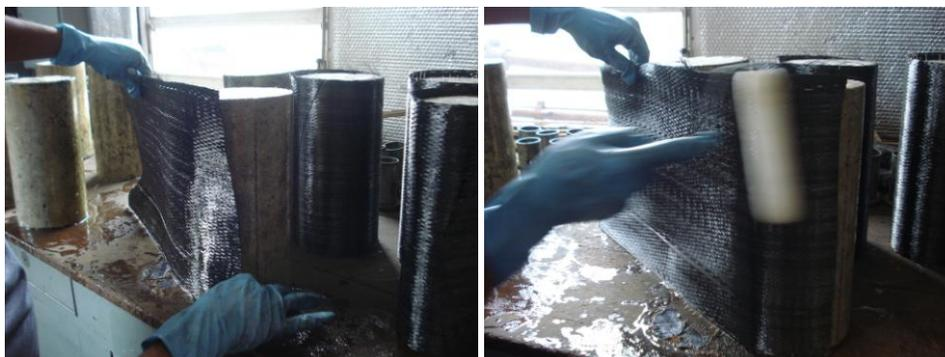
**Figura 9.3** – Aplicação do tecido de fibra de carbono
