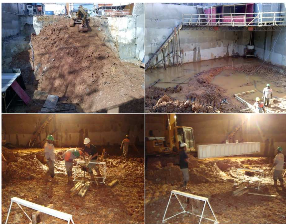
Figura 5.12: Montagem de viga de reação para prova de carga sobre placa.
