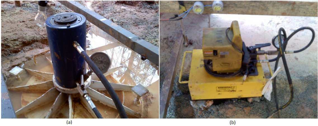
Figura 5.16: (a) Macaco hidráulico e (b) bomba elétrica.
