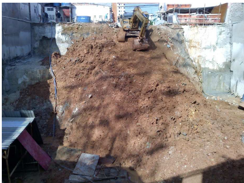
Figura 5.9: Acesso por rampa da obra.
