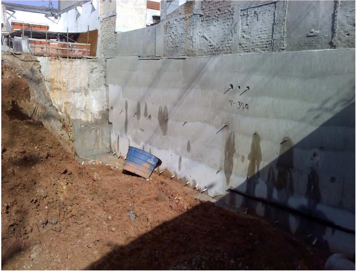
Figura 5.5: Contenção em solo grampeado
