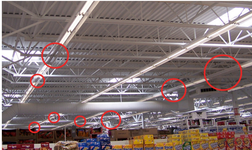
Figura 12 - Edificação comercial investigada pelo LRC (2006).
