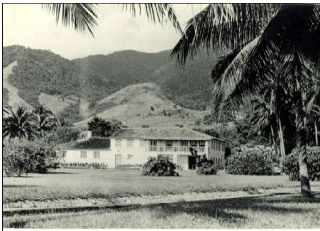
Figura 1. 5. Engenho D'Água na primeira metade do século XX (fonte: acervo Secretaria de Cultura de Ilhabela), evidenciando o desmatamento encosta acima.
