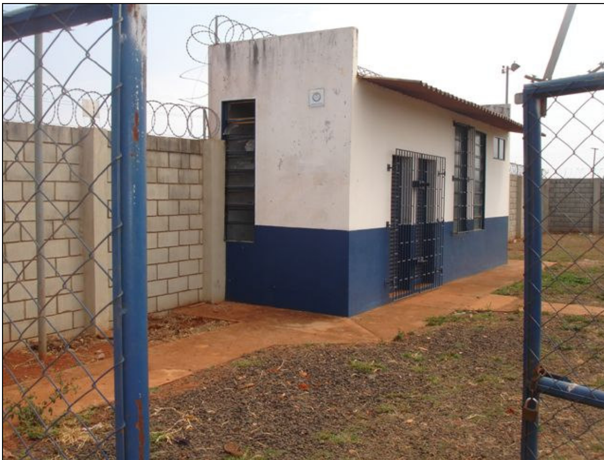
Figura 7.17 Acesso da Elevatória Joana D'arc B02 19.
