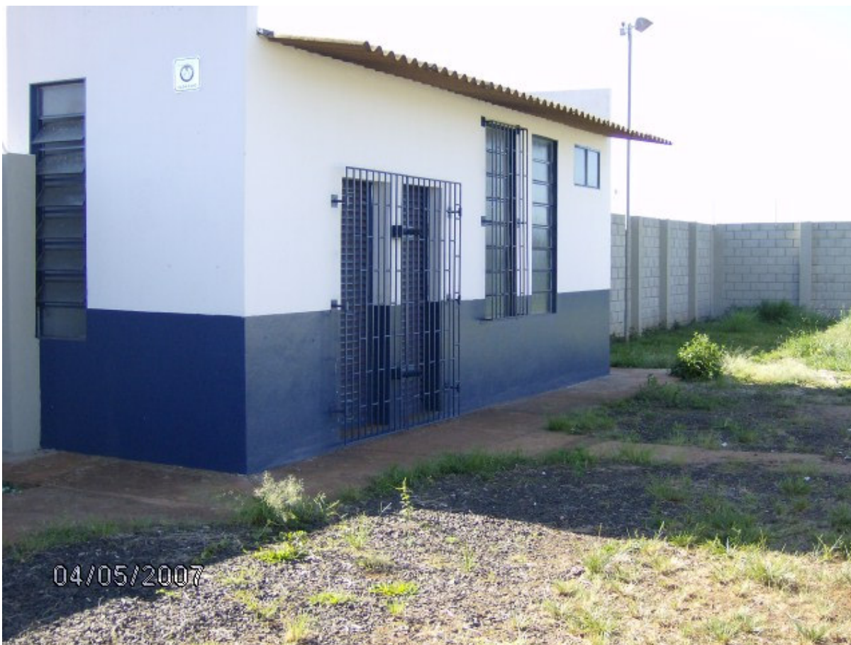
Figura 7.9 Unidades complementares da elevatória Joana D'arc B01 18
