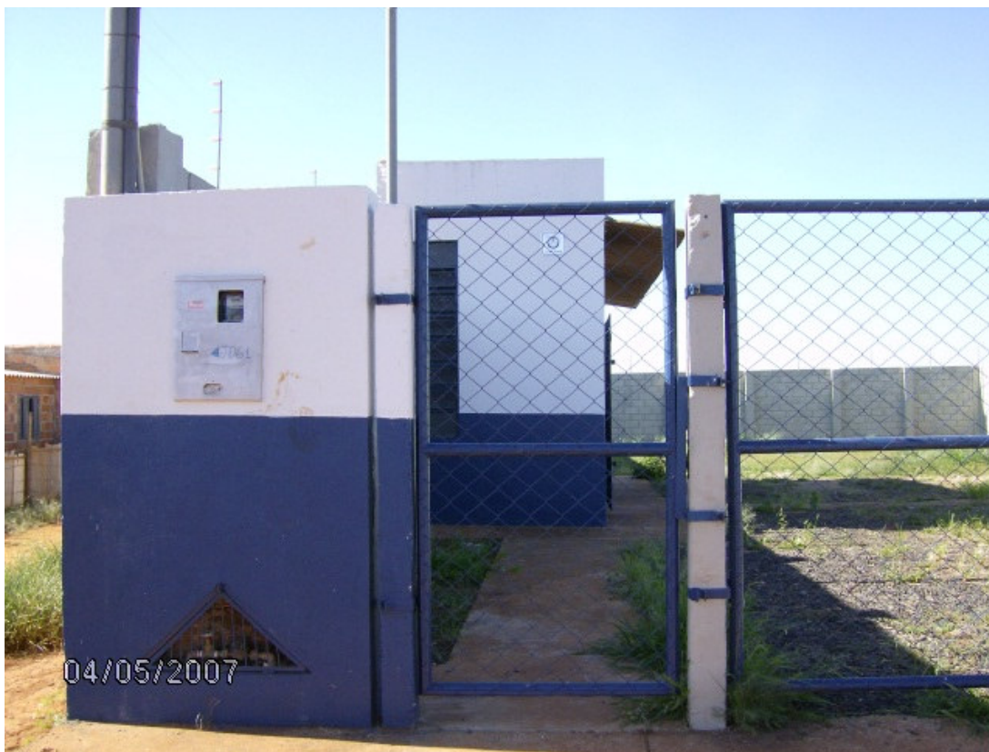
Figura 7.7 Fachada da Elevatória Joana D'arc B01 18
