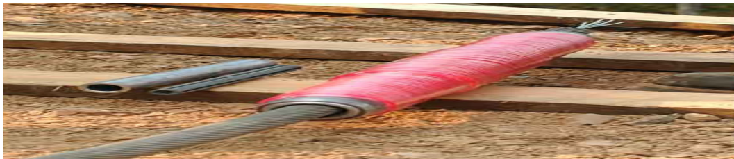
Fig. 6.1 A emenda explosiva pronta para detonação (www.Burndy.com)
