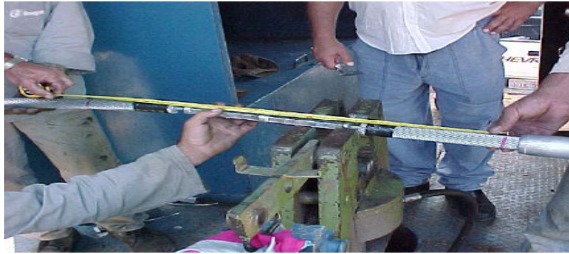
Fig.8.6 Marcação no cabo para centralizar a luva de alumínio
