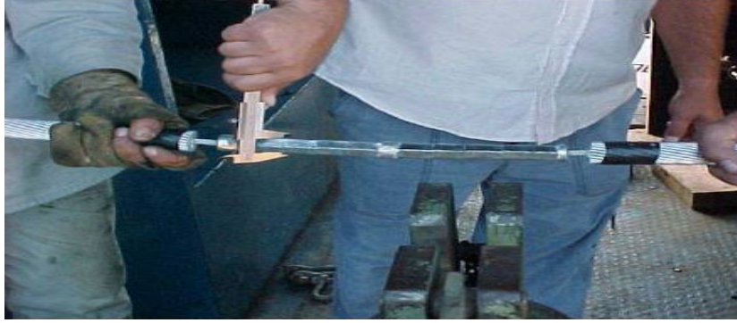
Fig. 8.5 Conferência das medidas da luva de aço após prensagem
