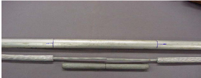
Fig. 8.2 Luvas de aço e de alumínio e Cabo preparado para montagem
