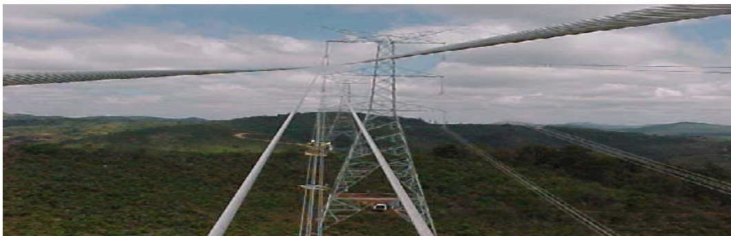
Fig. 1.2 Ambiente de trabalho de substituição de emendas na linha construída
