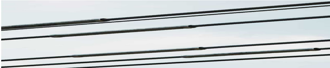
Fig. 6.2. Emendas e Luvas implosivas terminadas (www.Burndy.com)
