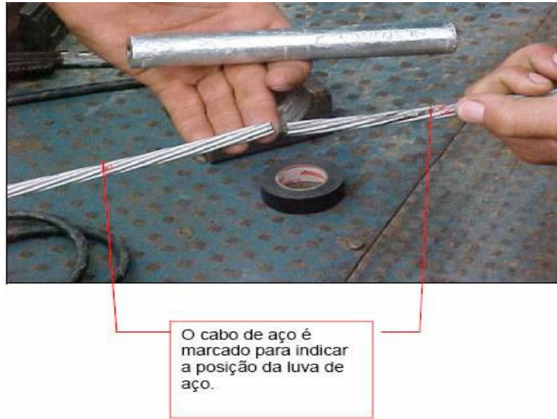
Fig. 8.4a Marcas para centralizar a luva de aço no cabo
