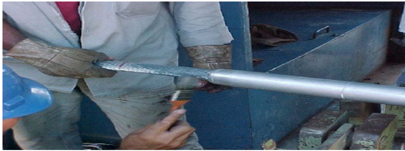
Fig. 8.8 Colocação de composto antioxidante(Sikronil) antes da prensagem da luva de alumínio
