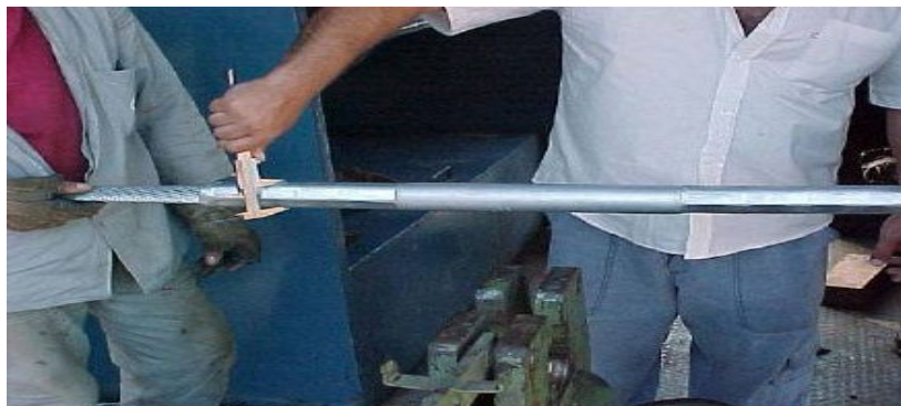
Fig. 8.10 Conferência das medidas da luva de alumínio após prensagem
