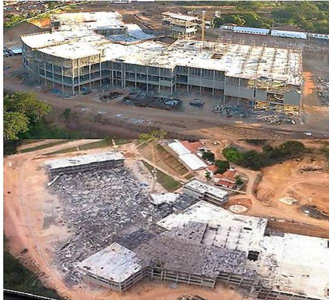
**Figura 1.4 - Acidente estrutural durante a construção do Shopping Rio Poty**
