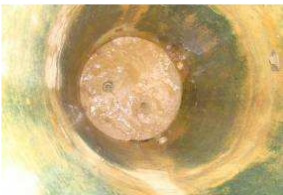
Figura 144. Vista superior dos furos de sondagem – ETA Rio Solimões
