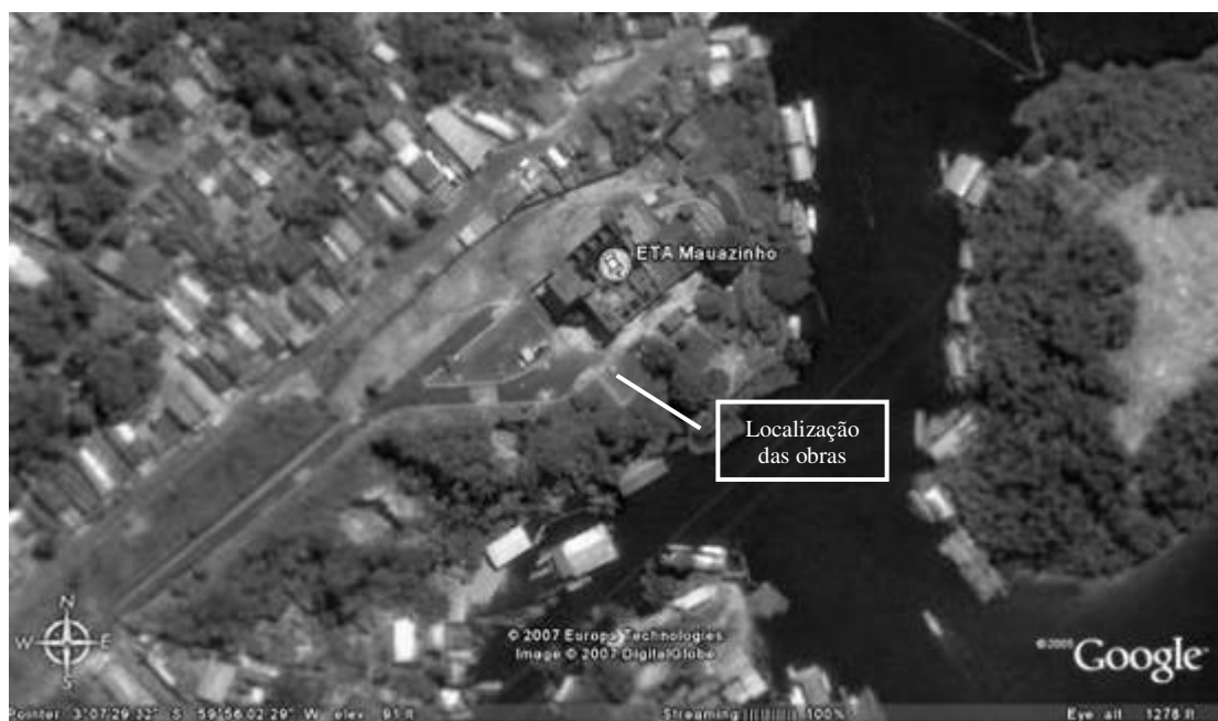
Figura 2: Localização das obras a partir da ETA Mauzinho Adaptado de Google Earth
