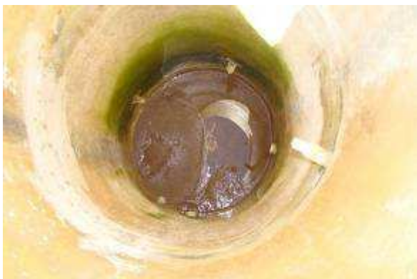
Figura 84: Esvaziamento do FL pelo Piezômetro na ETA Rio Negro
