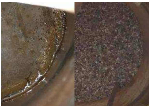
Figura 68: Inserção de camadas granulares a partir do fundo dos FLs, necessárias em função da deterioração da tela de aço inox
