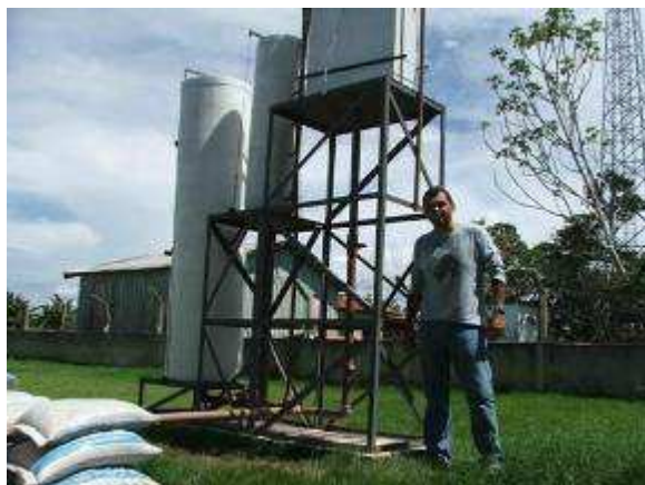
Figura 58: Montagem da ETA Rio Solimões
