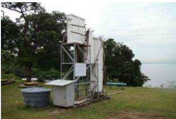
Figura 77: Aspecto geral da ETA Rio Negro após a finalização das intervenções
