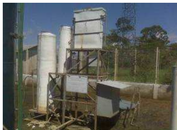
Figura 99: Final do alagamento na área da ETA Rio Solimões em 01/08/09 - reinício da operação da mesma
