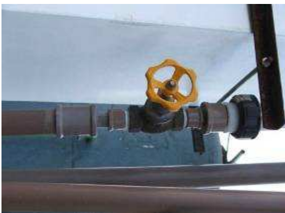
Figura 66: Válvula do tipo globo inserida à montante e à jusante do PFD
