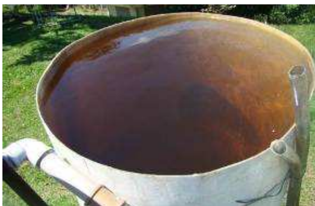
Figura 82: Lâmina d'água de 144 cm sobre o FL da ETA Rio Negro
