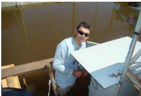
Figura 96: Pico da cheia do Rio Solimões – Painel elétrico da ETA Rio Solimões em 28/07/09
