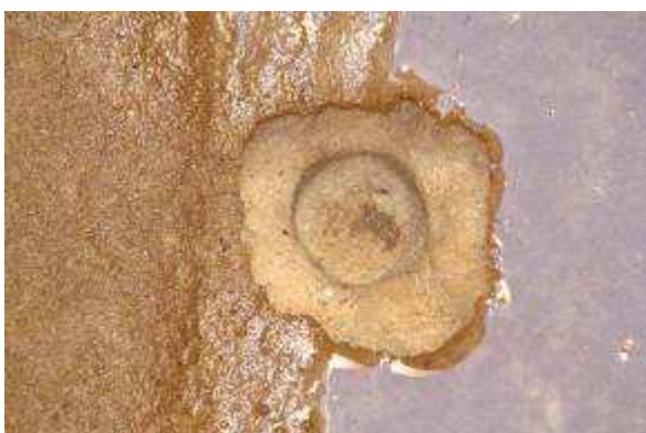
Figura 86: Aspecto da camada biológica e do furo nesta camada no FL na ETA Rio Negro
