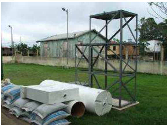
Figura 57: Início da montagem da ETA Rio Solimões
