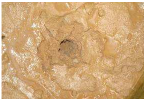
Figura 139. Vista superior do furo da sondagem – ETA Rio Solimões
