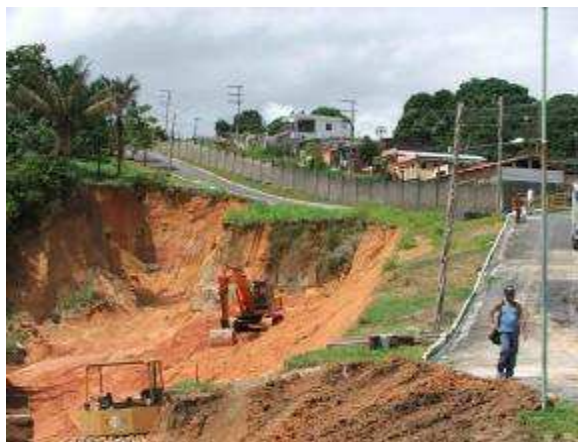
Figura 61: Recuperação da encosta na área interna da ETA Mauazinho
