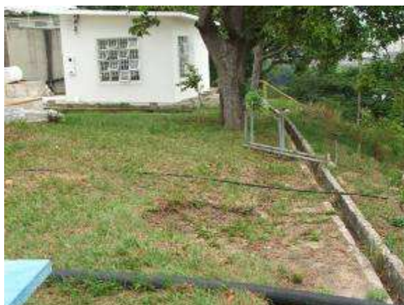
Figura 50: Local da Instalação da ETA Rio Negro, em Manaus-AM
