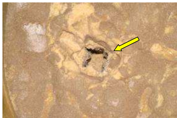
Figura 119. Vista superior do furo da sondagem – ETA Rio Negro
