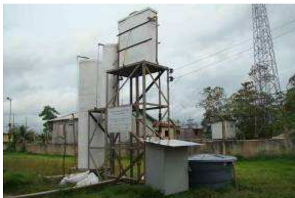
Figura 78: Aspecto geral da ETA Rio Solimões após a finalização das intervenções
