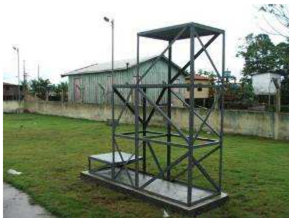
Figura 56: Obra civil necessária para a Instalação da ETA Rio Solimões
