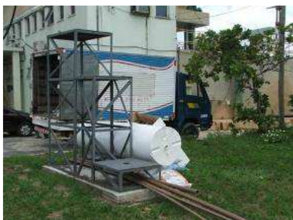
Figura 52: Início da montagem da ETA Rio Negro
