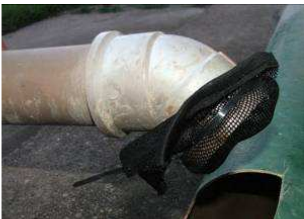
Figura 72: Tela colocada na tubulação de água excedente dos PFDs
