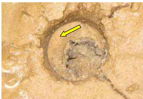
Figura 141. Vista da camada de areia intermediária (abaixo do schmutzdecke superior) – ETA Rio Solimões
