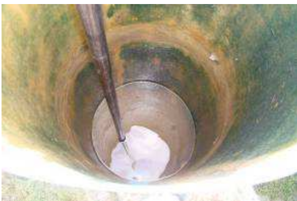
Figura 138. Vista superior da sondagem com dispositivo de perfuração – ETA Rio Solimões
