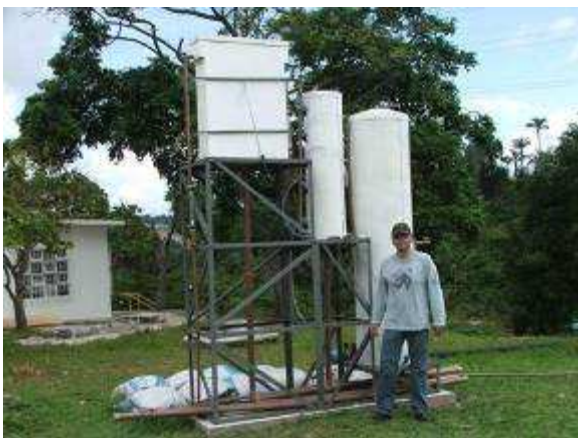
Figura 53: Montagem da ETA Rio Negro
