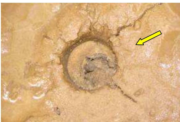
Figura 140. Aspecto do schmutzdecke superior – ETA Rio Solimões
