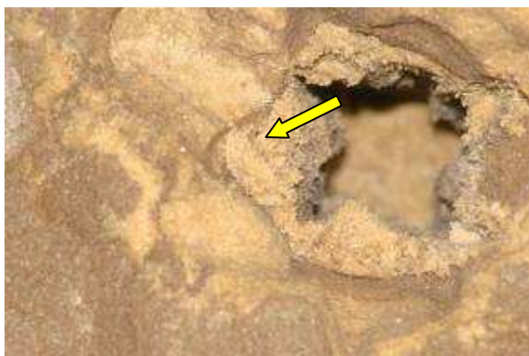
Figura 121. Vista da camada de areia intermediária (abaixo do schmutzdecke superior) – ETA Rio Negro
