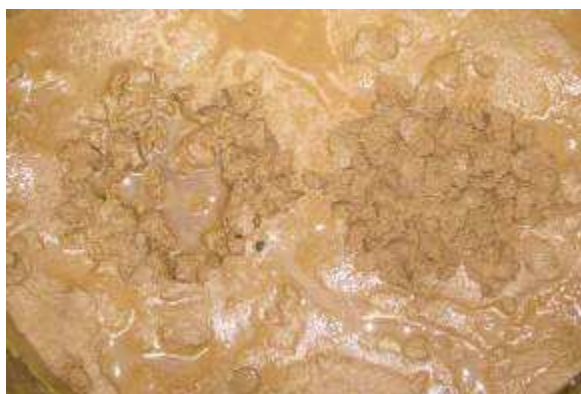
Figura 145. Revolvimento do schmutzdecke após a sondagem – ETA Rio Solimões
