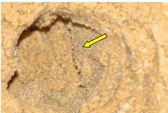
Figura 142. Vista do schmutzdecke inferior (abaixo da camada de areia)– ETA Rio Solimões
