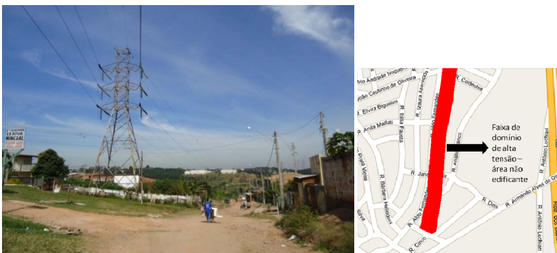
Figura 37: Faixa de domínio da linha de alta tensão – CPFL (com respectiva localização no mapa). Ocupações irregulares na extensão da faixa destinada à não edificação.
