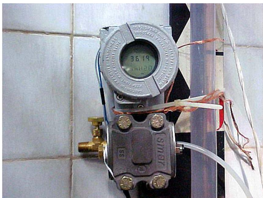
Figura 4.7 – Transmissor de pressão SMAR instalado para leitura e aquisição dos dados de nível da caixa de sucção
