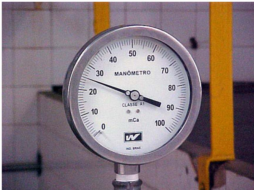
Figura 4.10 – Manômetro instalado na saída do bombeamento
