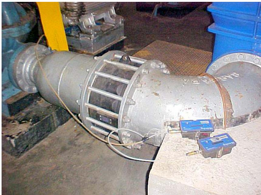
Figura 4.5 – Posicionamento dos data-loggers de pressão no sistema de bombeamento
