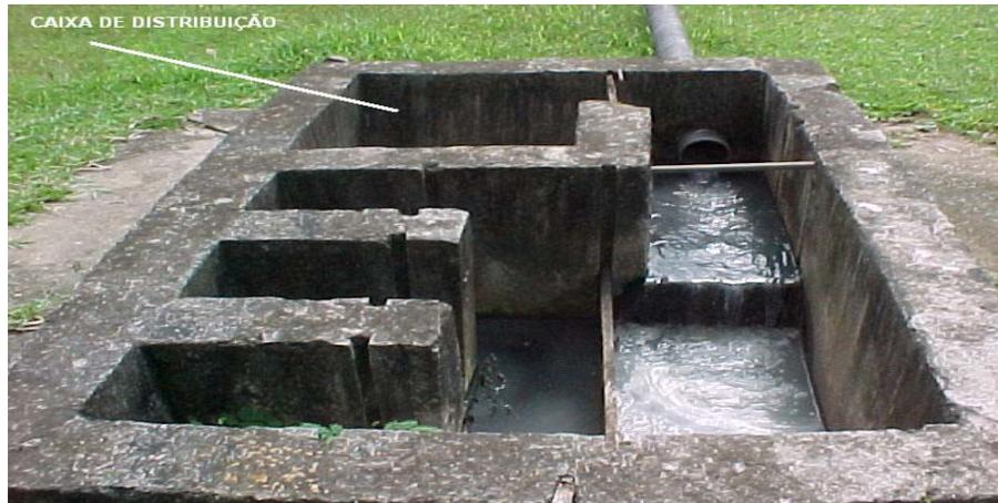
Figura 4.3 – Detalhe da caixa de distribuição de esgoto da ETE Icarai
