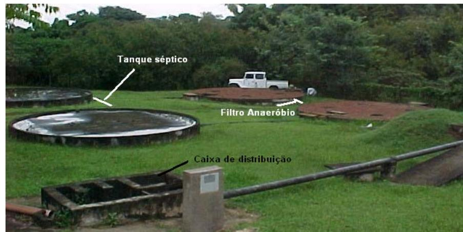
Figura 4.2: Vista geral da Estação de Tratamento de Esgotos - Jardim Icarai
