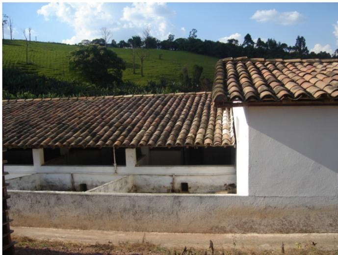
Figura 5.73. - Telhas cerâmicas de maior dimensão, utilizadas nas antigas construções
