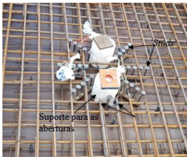
Figura 4.81 - Fotografia da armadura de flexão antes da concretagem.
