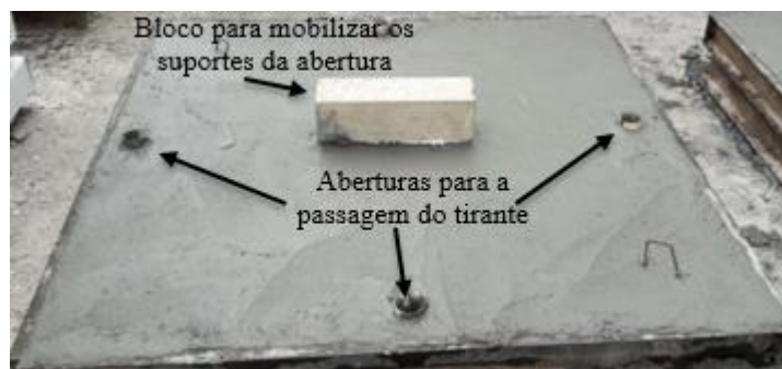
Figura 3.17 - Fotografia após a concretagem.
