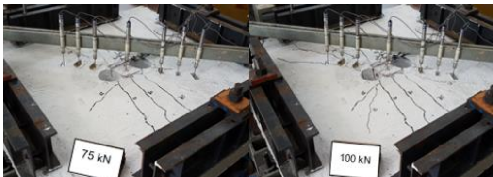
Figura 4.67: Desenvolvimento das fissuras da laje L2-150.
