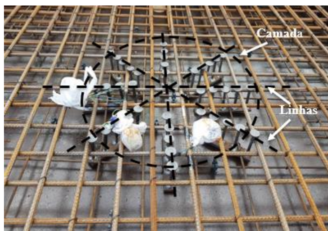
Figura 3.15 – Armadura de cisalhamento da laje LR-8s posicionada para receber o concreto.
