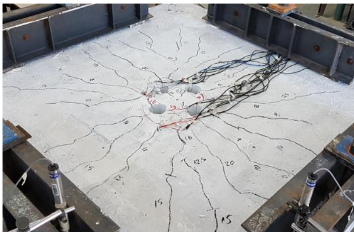
Figura 4.53 – Laje L4-75-4s pós ruptura.
