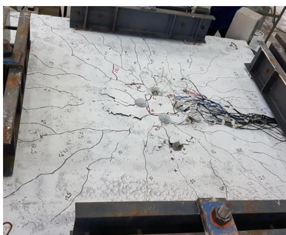
Figura 4.47 - Laje L4-75-8s pós ruptura.
