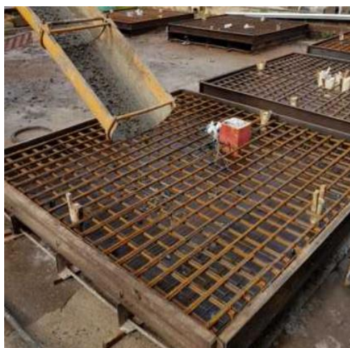
Lajes prontas para a concretagem
