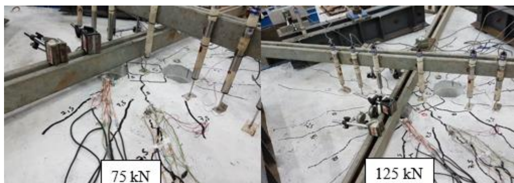
Figura 4.71 - Desenvolvimento das fissuras da laje L2-150-6s.
