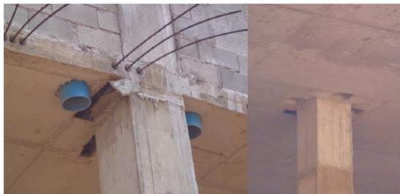
Figura 1.2 - Aberturas existentes nas lajes, próximas às faces dos pilares do Shopping Rio Poty.
