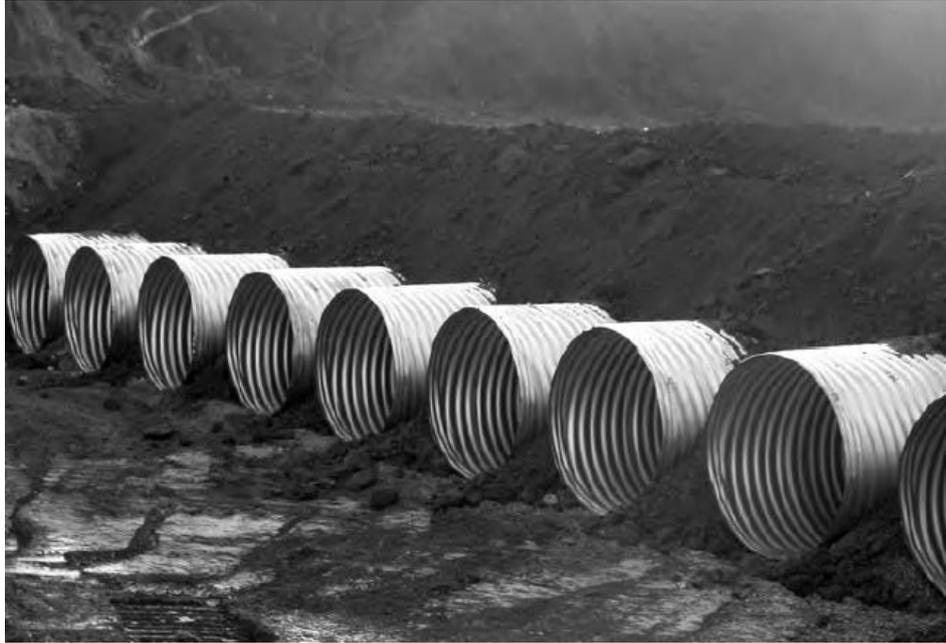
**Figura 1 - Sistema de drenagem utilizando tubulações metálicas corrugadas (NCSPA, 2008).**
