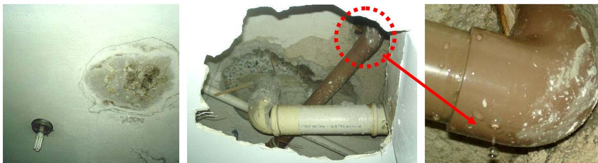
Figura 1.5 – Mancha de umidade em teto de banheiro causada por condensação de umidade na tubulação de água fria, erroneamente atribuída a vazamento
