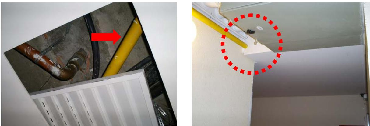
Figura 5.17 – Exemplo de medida de curto prazo: adequação de tubulação de gás correndo dentro de forro falso desprovido de tubo-luva ventilado nas extremidades
