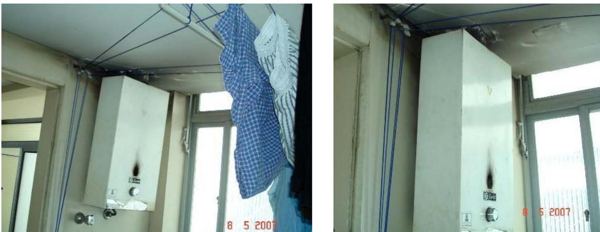
Figura 5.6 – Vistoria inicial: constatação de patologia que representa risco à vida – aquecedor de passagem a gás desprovido de chaminé individual e instalado em ambiente sem aberturas de ventilação permanente
