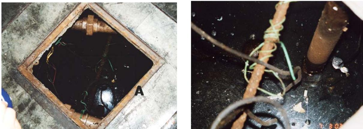
Figura 2.28 – Presença de partículas finas de solo em suspensão dentro do poço de drenagem do subsolo indicativas da inexistência de mantas geotêxteis envolventes às valas
