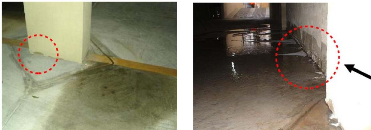
Figura 2.29 – Afloramento de água de lençol no piso do subsolo devido à colmatação das valas drenantes
