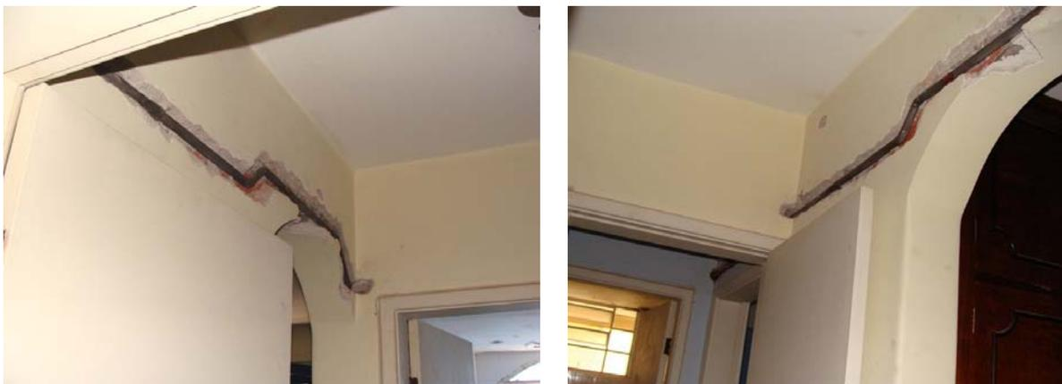
Figura 5.19 – Exemplo de medida de longo prazo: correção, por ocasião de reforma, de discreto colo alto (sifão) em tubulação de distribuição de água fria segregando ar e reduzindo a vazão
