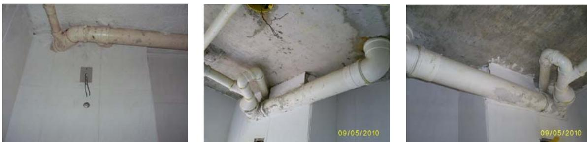
Figura 2.1 – Desconforto psicológico causado pela inexistência de forros falsos em banheiros de HIS
