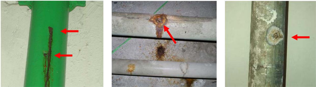
Figura 2.32 – Exemplo de anomalia exógena funcional: corrosão por pite em tubos de ferro fundido e de aço
