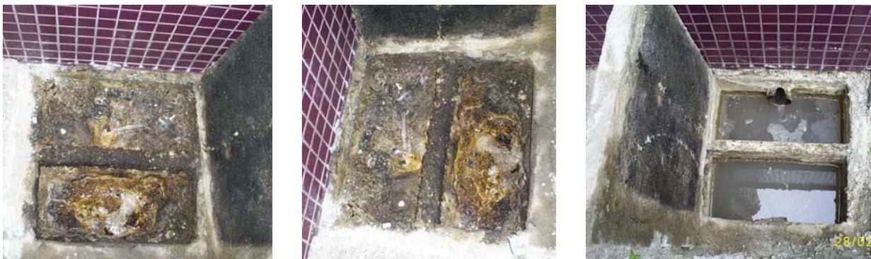
Figura 5.5 – Vistoria inicial: constatação de falha de manutenção – caixa de gordura saturada de material graxo retido (esq. e centro), ocasionando entupimento no escoamento de esgoto, e depois de limpa (dir.)
