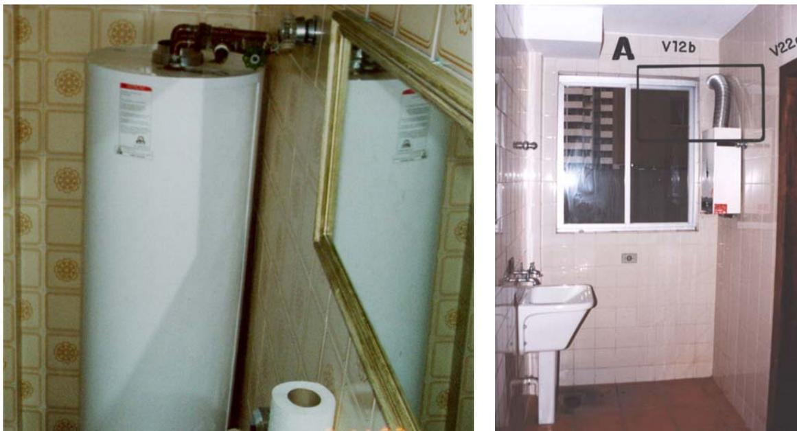
Figura 5.15 – Exemplo de medida urgente: recomendação de imediata desativação de aquecedor a gás desprovido de chaminé, instalado dentro de ambiente sem aberturas de ventilação permanente
