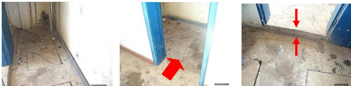
Figura 5.16 - Exemplo de medida urgente: recomendação de construção de soleira elevada na porta de acesso à laje de tampa de reservatório de água potável e construção de golas nas aberturas de inspeção
