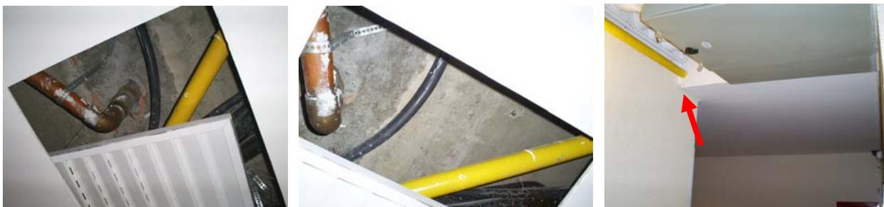
Figura 2.37 – Exemplo de defeito construtivo: tubulação de gás dentro de forro falso desprovida de tubo-luva
