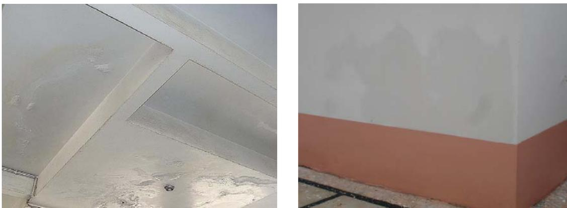
Figura 2.19 – Presença de umidade em laje rebaxada (esq.) e em parede externa de banheiro (dir.) sugestivas da ocorrência de vazamentos a partir de tubulações embutidas
