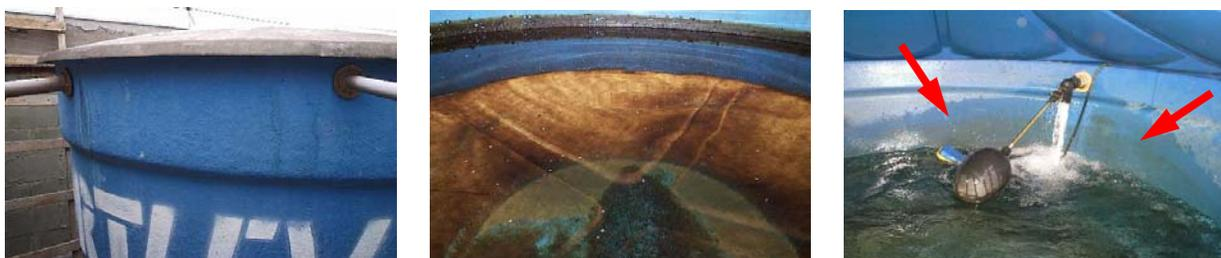
Figura 2.47 – Presença de biofilme na parede interna de reservatório doméstico de água fria
