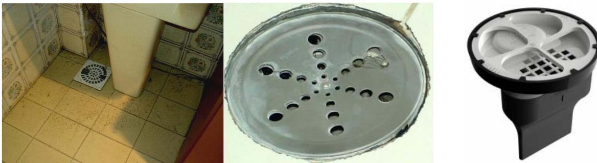
Figura 5.21 – Exemplos de medidas paliativas: adoção de grelha retrátil em caixa sifonada sujeita a refluxo de esgoto por ação de sobrepressão (esq. e centro) ou substituição por dispositivo antiespuma (dir.)
