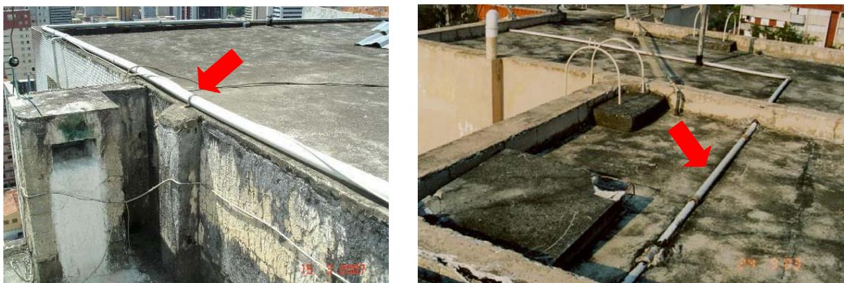
Figura 5.20 – Exemplo de medida paliativa: pintar com tinta refletiva de alto brilho trechos esbranquiçados de tubos de PVC marrom expostos à radiação ultravioleta
