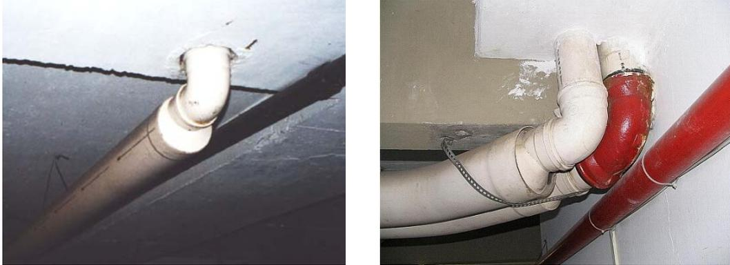
Figura 5.8 – Exemplo de erro de dimensionamento que gera manutenção: aumento indevido da seção do coletor predial de esgoto ocasionando entupimentos frequentes
