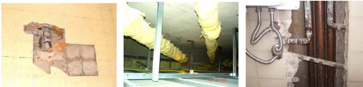
Figura 5.12 – Exemplos de dificuldades de acesso para inspeção: tubulações embutidas (esq.), dentro de forro falso (centro) e dentro de *shaft* de alvenaria sem acesso (dir.)
