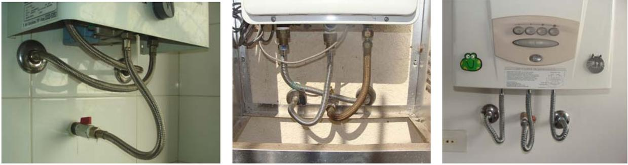
Figura 5.22 – Exemplos de simples registro da não conformidade de origem: inversão dos pontos de água fria e quente na ligação de aquecedor instantâneo (esq.) e instalação de pontos alinhados (centro e dir.)
