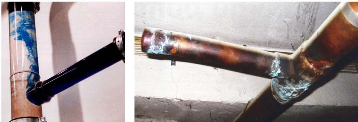
Figura 2.49 – Demonstração do arraste de água de um ramal inutilizado (trecho morto) (Fonte: HYDRO, 2008)
