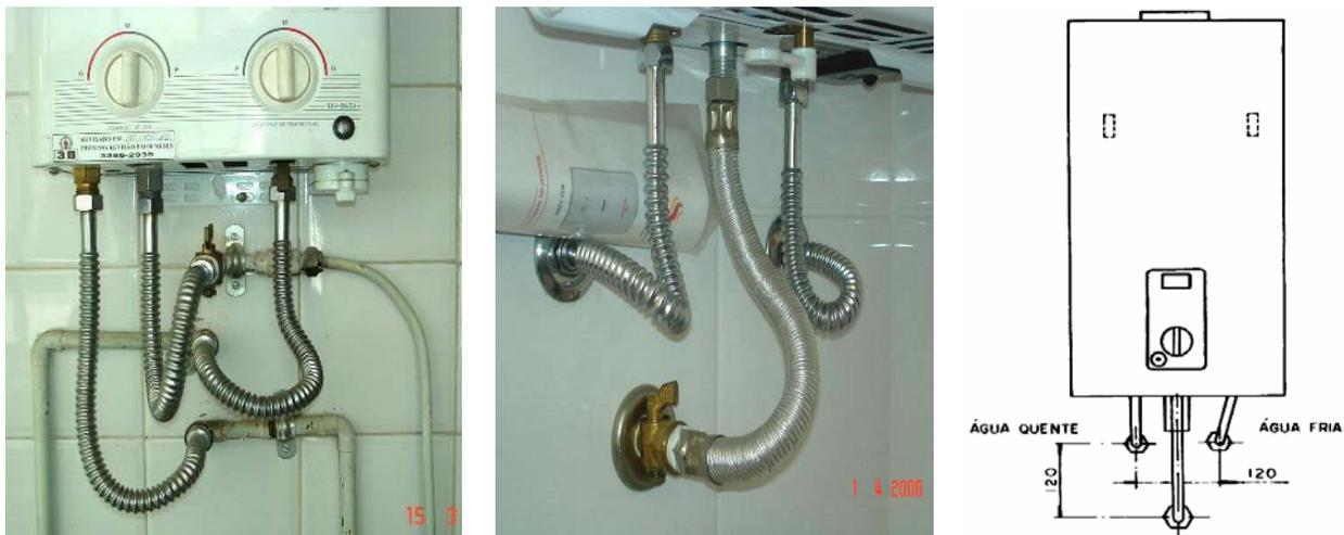
Figura 5.23 – Exemplos de simples registro da não conformidade de origem: alinhamento dos pontos de água fria e quente na ligação de aquecedor instantâneo (esq.) em desacordo com o padrão da ABNT (este mostrado na foto de centro e na figura à direita)
