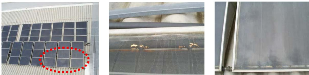
Figura 5.4 – Vistoria inicial: constatação de falta de manutenção – acúmulo de sujeira em placas solares cujo sistema de aquecimento apresenta elevado consumo energético complementar
