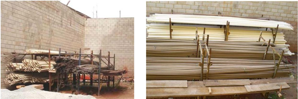
Figura 2.10 – Armazenamento inadequado de tubos plásticos no canteiro (exposição à radiação solar direta)
