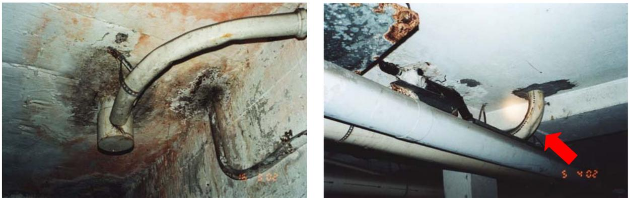
Figura 2.39 – Exemplos de não conformidade à boa técnica: conformação de curvas em tubos plásticos mediante aquecimento com chama de maçarico a gás
