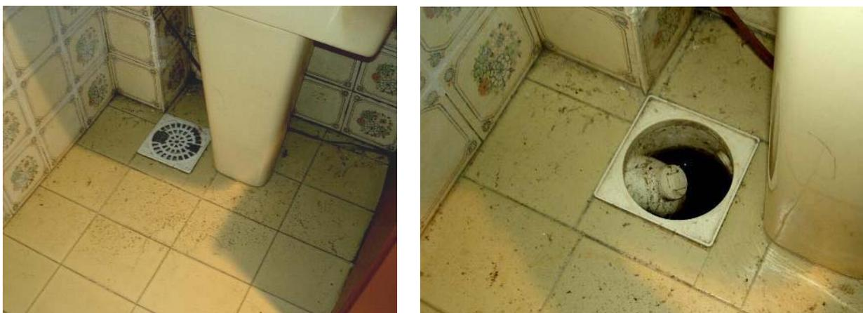
Figura B.1 – Resíduos particulados depositados no piso circundante de ralo sifonado de área de serviço objeto de refluxo de esgoto em simulação de descargas para constatação de sobrepressão (Fonte: Edifício EE1)
