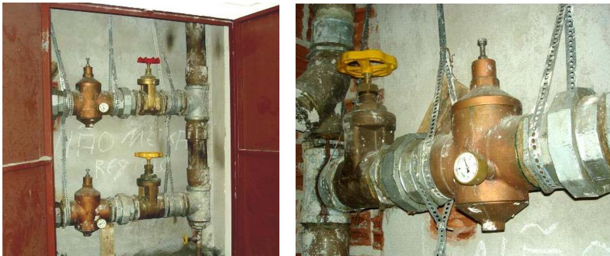
Figura B.4 – Existência de pares galvânicos entre conexões de ferro fundido maleável galvanizado e válvulas de bronze na central redutora de pressão (Fonte: Edifício EE1 – Curitiba, PR)
