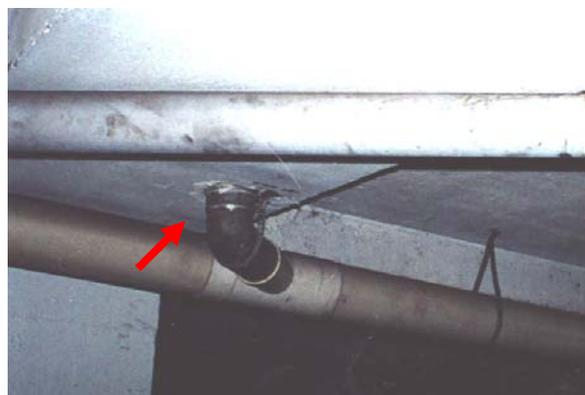
Figura 2.5 – Interferências de tubulações com vigas por falta de prévia compatibilização entre projetos
