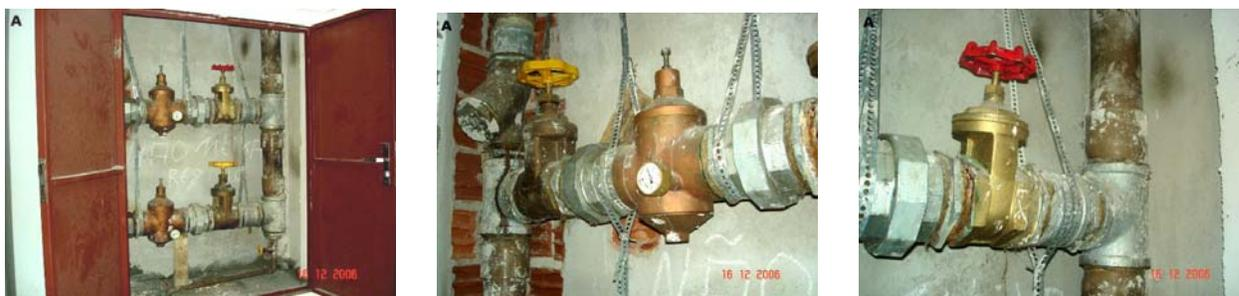
Figura 5.13 – Exemplo de dificuldade na estimativa da ocorrência da manifestação patológica na fase de prognóstico: constatação de par galvânico sem indício aparente de corrosão nas conexões de ferro galvanizado
