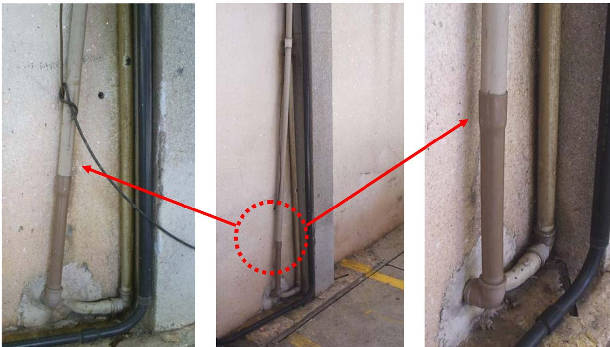
Figura 2.31 – Exemplo de anomalia exógena natural: reparo de vazamento na base de tubo de PVC marrom exposto à radiação solar direta sofrendo degradação, esbranquiçamento e fissuramento.
