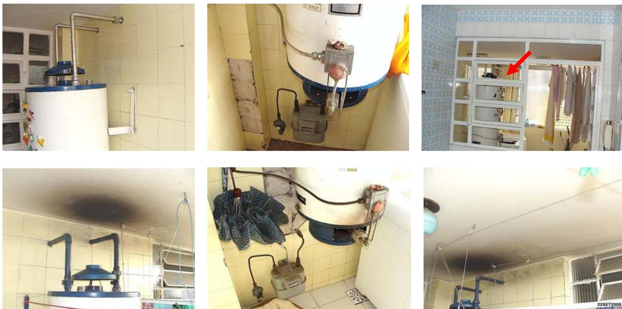
Figura 5.14 – Exemplo de medida urgente: recomendação de imediata desativação de aquecedor a gás desprovido de chaminé, instalado em local sem aberturas de ventilação permanente.
