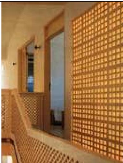
**Figura 2.29:** Exemplo de aplicação de cobogó. Pátios Internos. Fonte: <http://www.arq.ufsc.br/~labcon/arq5661/Aberturas3/janelas6.html>
