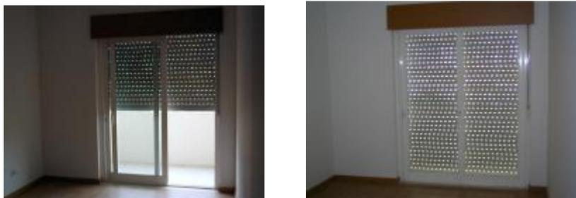
**Figura 4.7:** Persianas em rolo utilizadas como proteção da iluminação nos edifícios. Situações metade fechada (a) e totalmente fechada (b). Fonte: Patrício e Bragança (2003)
