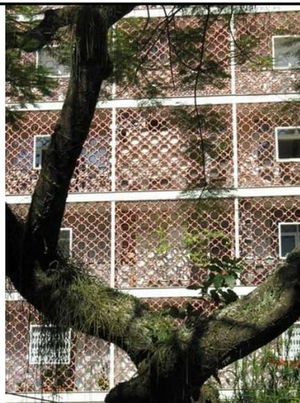
**Figura 2.26:** Exemplo de aplicação de cobogó.
