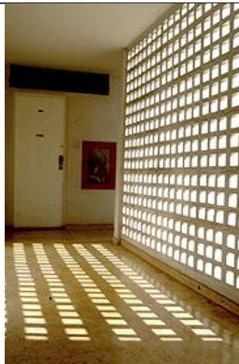
**Figura 2.30:** Exemplo de aplicação de cobogó. Corredores. Fonte: <http://www.skyscrapercity.com/showthread.php?t=509007>
