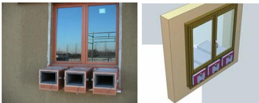
**Figura 4.10:** Janela híbrida do “Programa Teria”. Fonte: acesso eletrônico, <http://www.cstb.fr/actualites/webzine/thematiques/acoustique/projet-teria-pour-concilier-confort-thermique-et-acoustique.html> em 08/04/2010 em 08/04/2010
