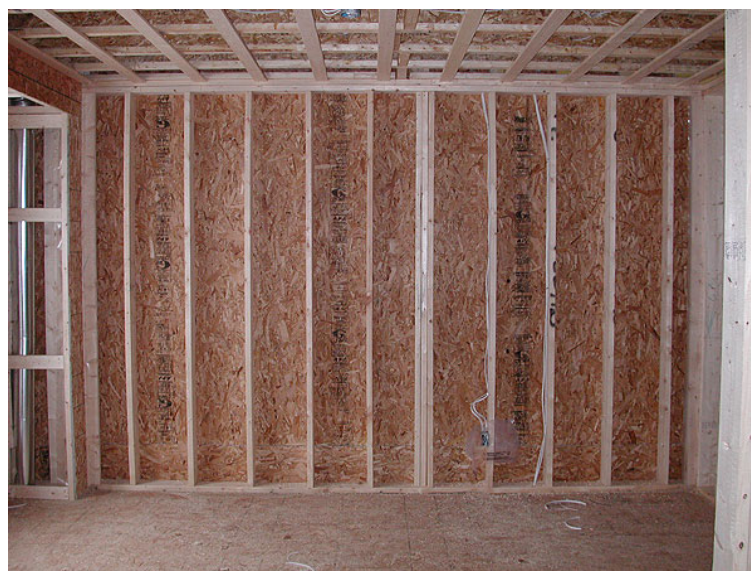
Figura nº 37– Detalhe da estrutura em Wood Frame .
