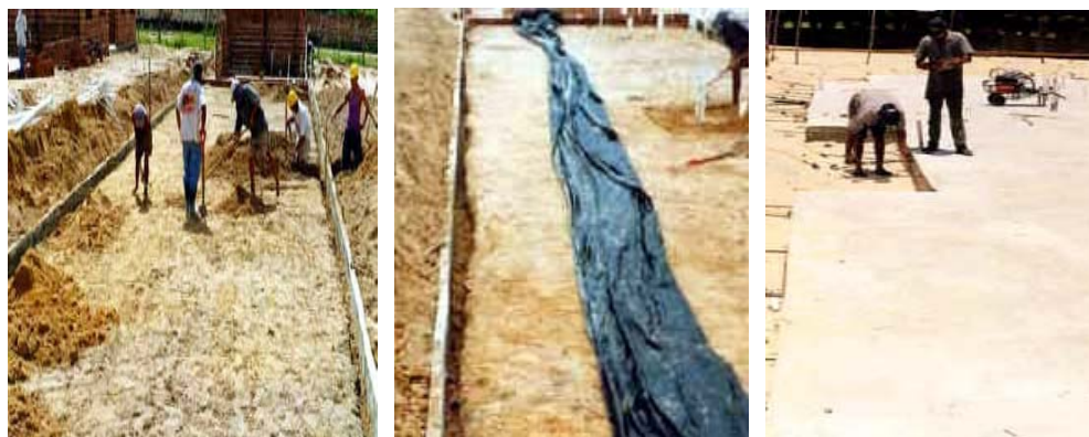
Figura nº 36– Detalhe do Radier. Fonte: www.metalica.com.br , acesso 01/07//2005.
