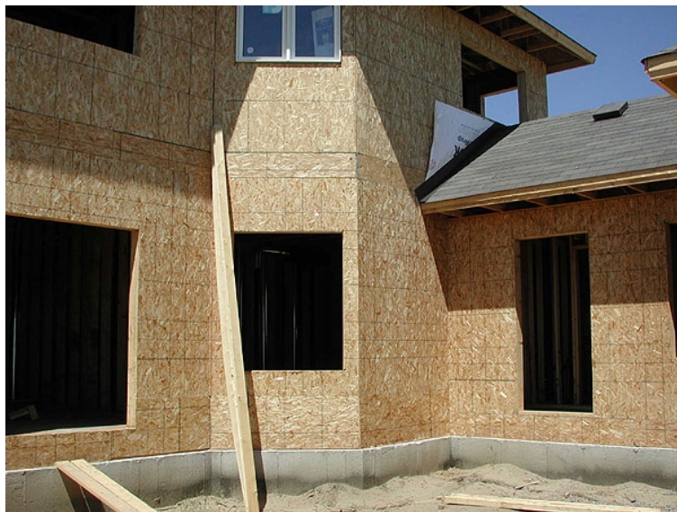
Figura nº 38– Fechamento externo em OSB. (Fonte: www.cwc.ca , acesso 01/07/2005).
