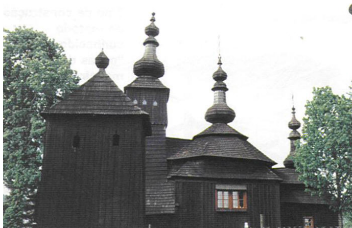
Figura nº 5 – Igreja ortodoxa Eslováquia/Ucrânia com placas verticais de revestimento (madeira). Fonte: Rosário, L. C., 1996.
