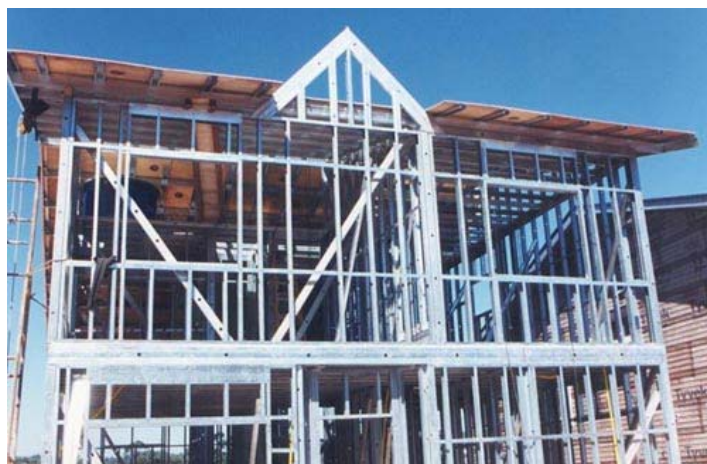
Figura nº 46 – Detalhe de montagem da estrutura em Steel Frame . (Fonte: www.construtorasequencia.com.br - acesso em 02/07/2005).
