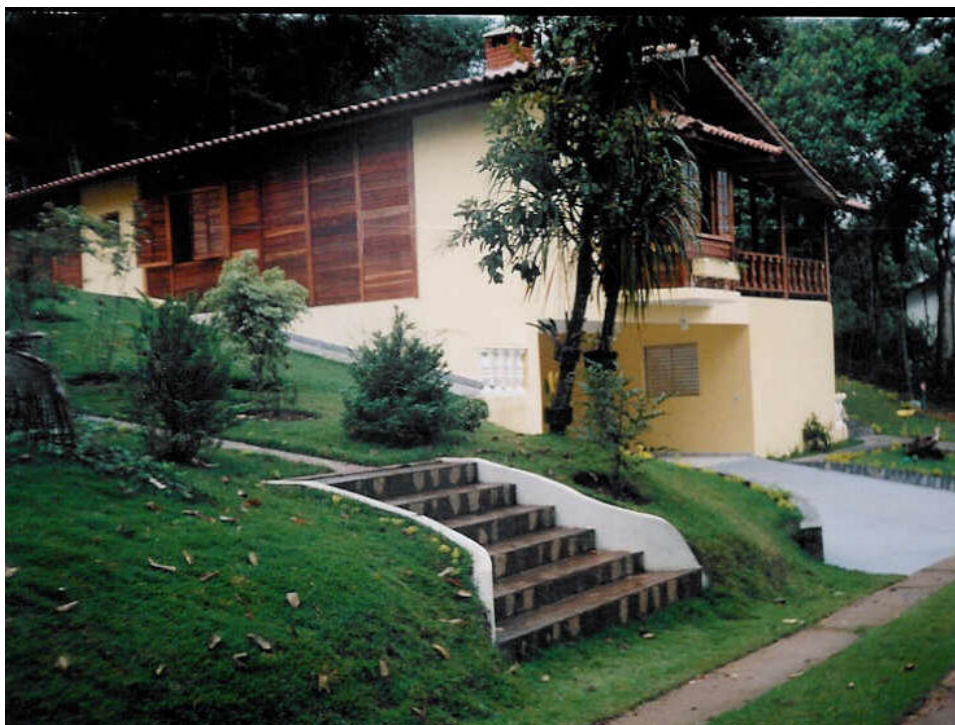
Figura nº 22 – Casa em estrutura mista.
