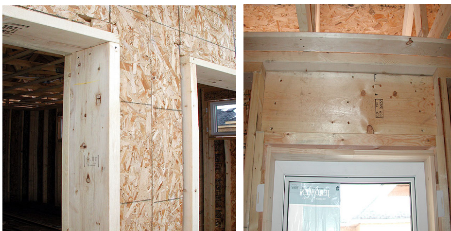
Figura nº 41 - Detalhe das esquadrias (Fonte: www.cwc.ca , acesso 01/07/2005).
