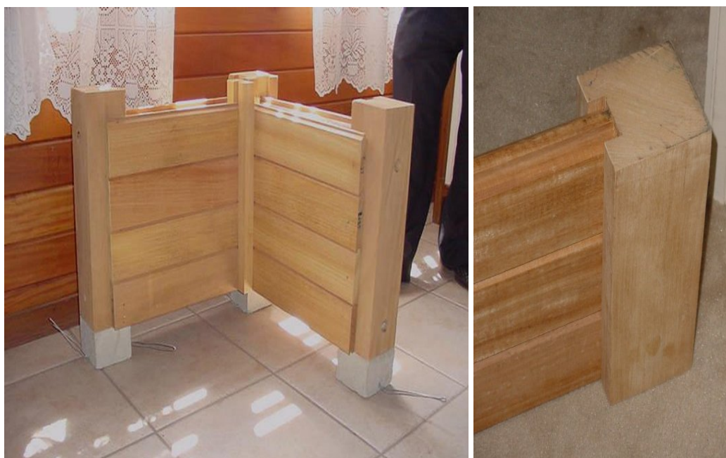
Figura nº 21 – Detalhe das colunas e paredes.
