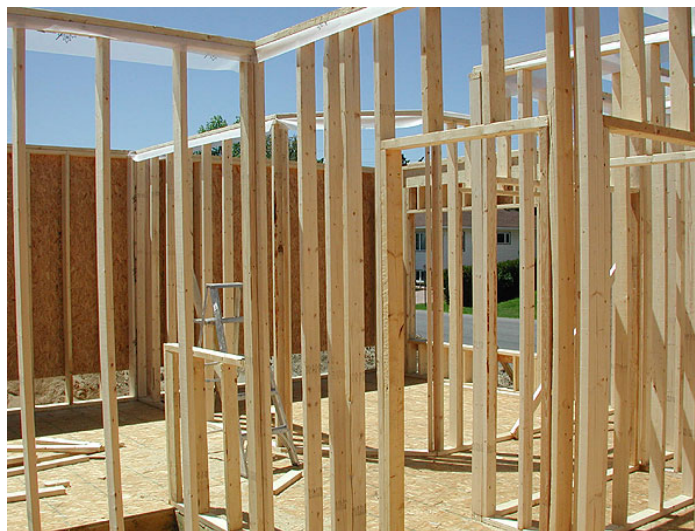
Figura nº 44 – Wood Frame . (Fonte: www.cwc.ca – acesso em 30/05/2005).
