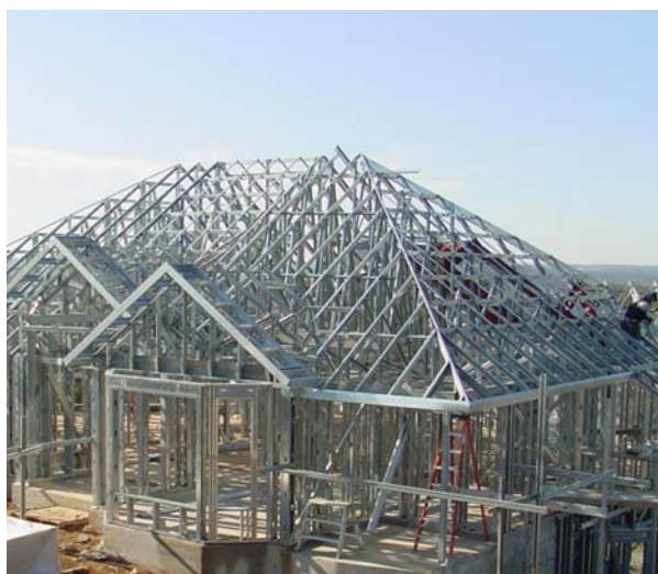
Figura nº 58 – Detalhe da estrutura do telhado.
