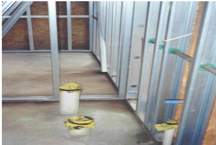
Figura nº 65 – (h), (i) Detalhe interno e (j) Detalhe de instalações. Condomínio Jardim das Paineiras (Fonte: Devanir Cabral Lima Morikawa).
