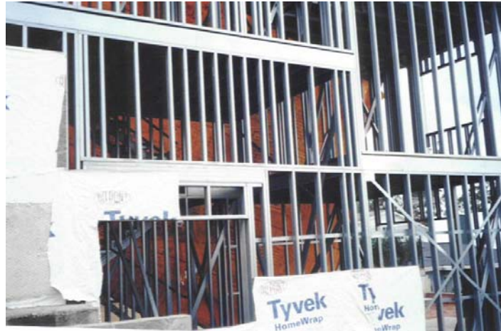
Figura nº 62 – (a) Detalhe externo da estrutura em aço. Condomínio Jardim das Paineiras. (Fonte: Devanir Cabral Lima Morikawa).
