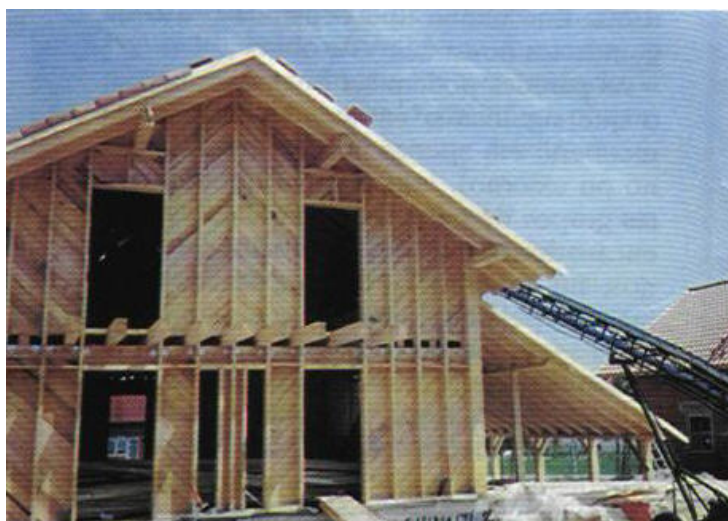
Figura nº 10 – Casa construída (Alemanha) no Sistema Balão. (Fonte: Rosário, L. C., 1996).
