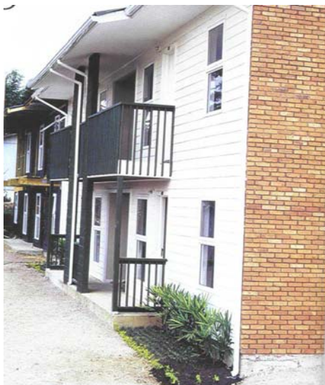
Figura nº 34 - Condomínio Porto Primavera, Curitiba. (Fonte: Revista Técnica nº 59, 2002).
