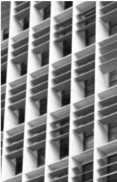
O edifício do Ministério da Educação e Saúde possui duas belas e imponentes fachadas, sendo uma totalmente envidraçada a sudeste, e a outra a noroeste, protegida por brise-soleil horizontal móvel, de cimento-amianto, na cor azul, fixado em esbeltas placas verticais e horizontais em concreto armado.
