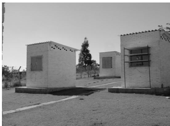
Fig. 4.54. Protótipos com brise-soleil horizontal. Ao lado o protótipo referência, e ao fundo o protótipo com elemento vazado.
