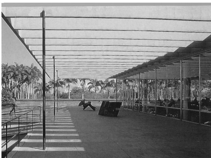
Fig. 3.13. Museu de Arte Moderna, 1953-68, Affonso E. Reidy, Rio de Janeiro. “A estrutura é indissociável da arquitetura, funcionando como elemento plástico”. No terraço, a pérgola em concreto é o sistema de sombreamento adotado, integrando e dando continuidade aos espaços interno e externo, com ritmo e vista da paisagem do mar. (CAVALCANTI, 2001). (Fonte da fotografia: BONDUKI, 2000)
