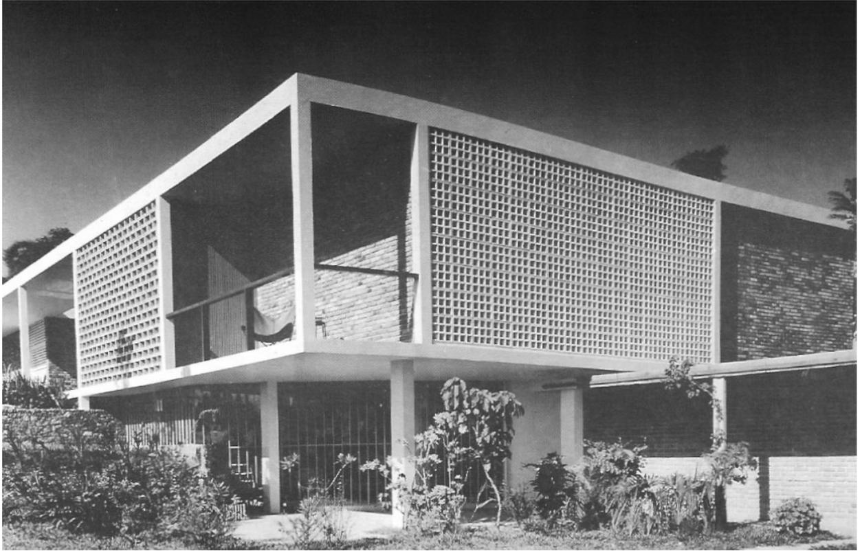
Fig. 3.26. Residência do Arquiteto Oswaldo Bratke – Morumbi, São Paulo, 1951. Essa edificação é um belo exemplo de composição geométrica. Possui um “recoo imposto pelas diferentes necessidades de proteção determinadas pela orientação de cada lado do plano. (...) Os painéis exteriores de cobogós de concreto pré-moldado corrigem o excesso de insolação e protegem a privacidade da casa”. (MINDLIN, 1956; foto SEGAWA, 1997).
