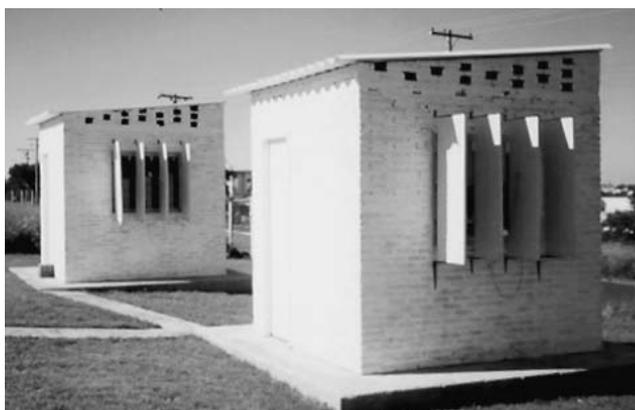
Fig. 4.53. Protótipos com o brise-soleil vertical de madeira e concreto.
