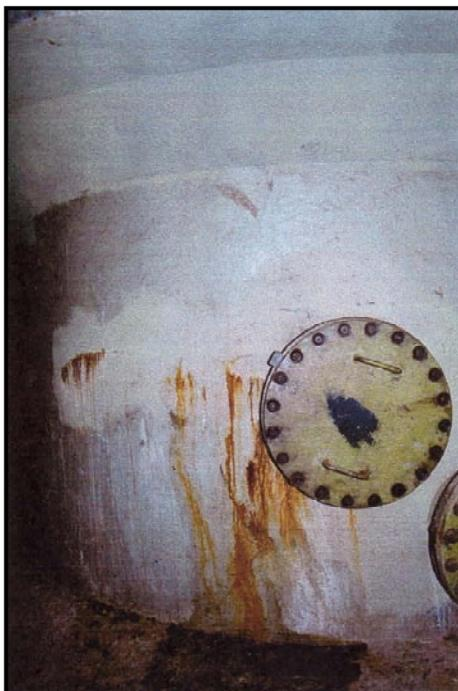
Figura 27 – Vazamentos na porção inferior do tanque junto aos bocais.
