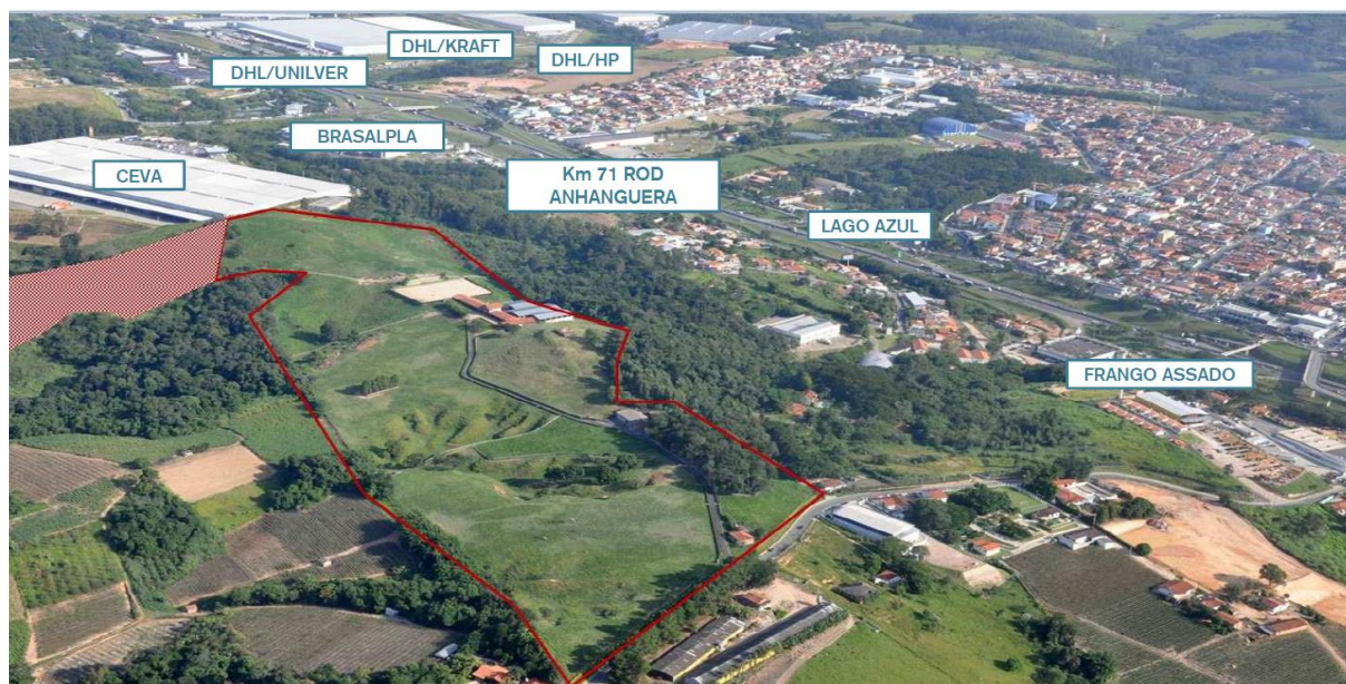
Figura 18 - Terreno do Empreendimento.
