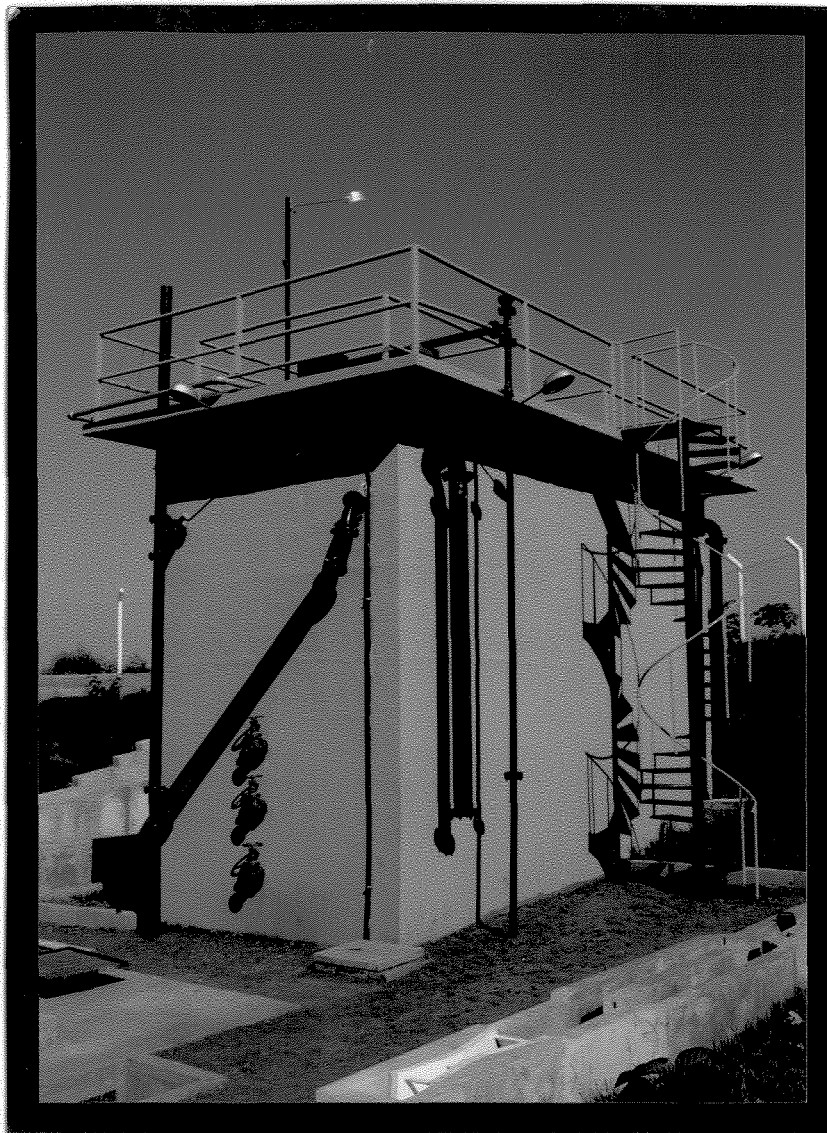
FIGURA 5: Detalhe dos três Pontos de Coleta de Amostra de Lodo e Tubulação de Saída do Efluente Tratado.
