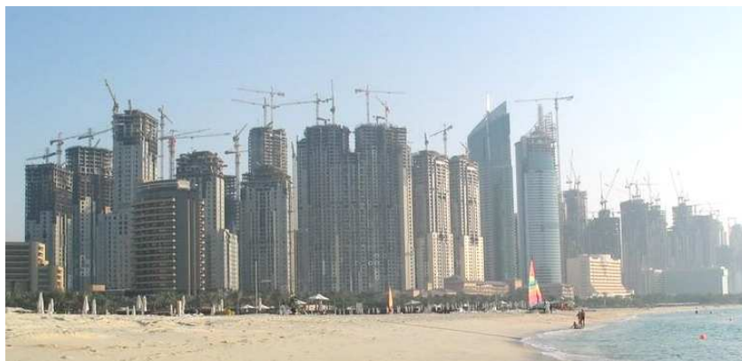
Figura 3.23 - Dubai possui 30% dos guindastes de construção do mundo (Fonte: Disponível em: < http://dubai.isnuts.googlepages.com/dubaiconstruc2222222.JPG >)
