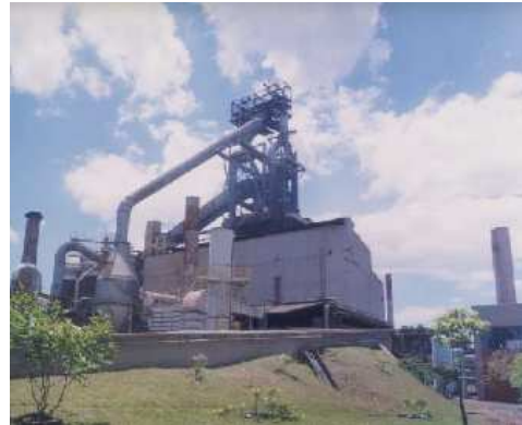
Figura 3.13 - Alto-forno na Açominas [Fonte: CBCA (2008)]
