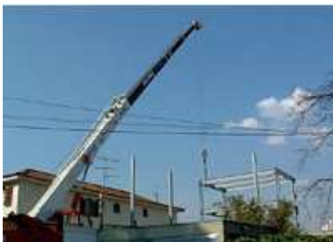
Figura 3.44 - Braço hidráulico de caminhão (munck) [Fonte: CBCA (2008)]
