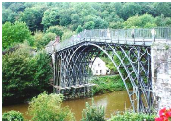
Figura 3.2 - Iron Bridge – Inglaterra (1779) [Fonte: CBCA (2008)]
