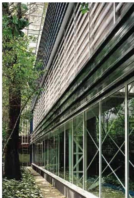
Figura 3.39 - Estrutura metálica do clube A Hebraica em São Paulo - detalhamento minucioso do projeto arquitetônico para que as interfaces ficassem bem-resolvidas. Projeto do escritório Barbosa & Corbucci. (Fonte: Revista Projeto Design, Edição 275, janeiro 2003)
