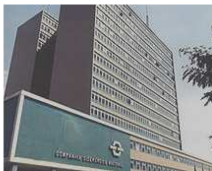
Figura 3.11 - Escritório Central da CSN Volta Redonda (1962) (Fonte: http://www.revistatechne.com.br/engenharia-civil/138/artigo102488-2.asp )
