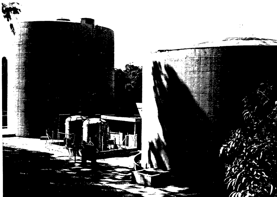
FIGURA 3.2- Reatores anaeróbios do sistema de tratamento de efluentes da CIA CAMPINEIRA DE ALIMENTOS. À esquerda, reator anaeróbio de mistura completa; à direita, reator anaeróbio de manta de lodo
