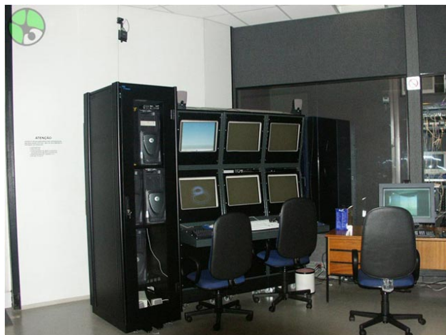
Figura 73. Equipamentos de projeção da Caverna Digital (USP, 2001).
