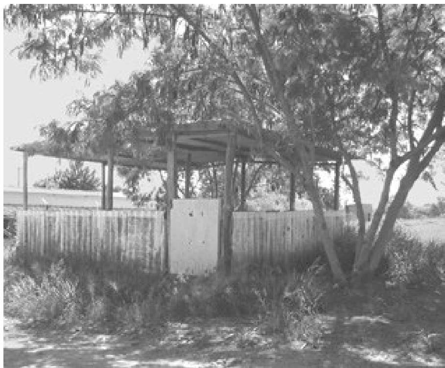
Figura 4.1 Galpão de caracterização do resíduo
