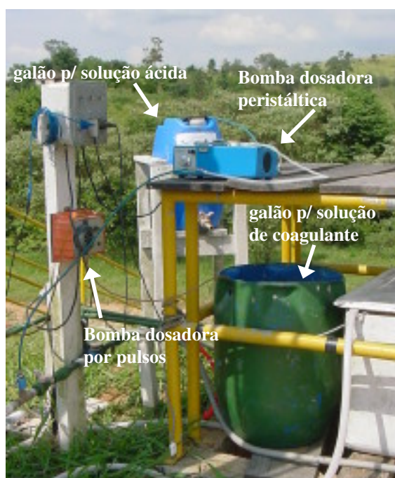
Figura 4.8 – Equipamentos para armazenamento e aplicação das soluções químicas
